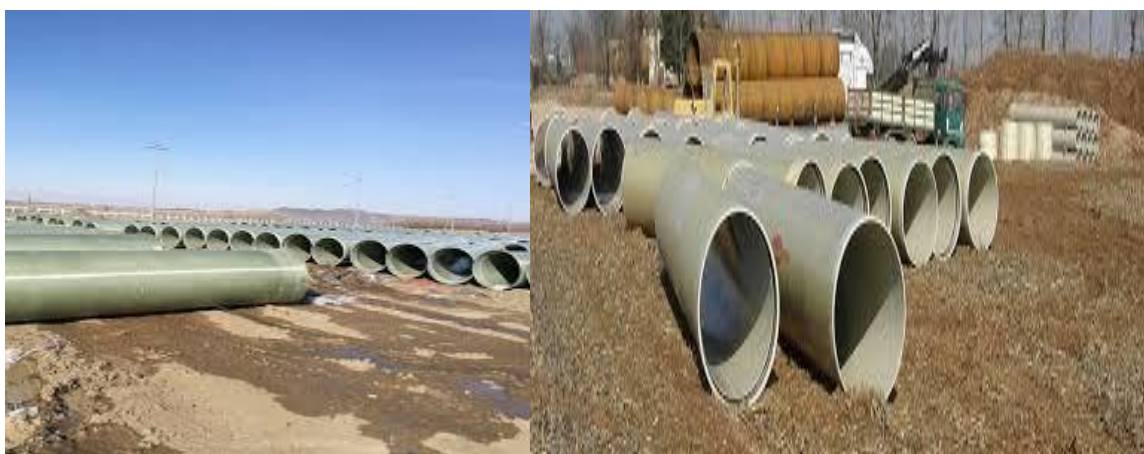
Figure (II.6) : conduite en PRV
