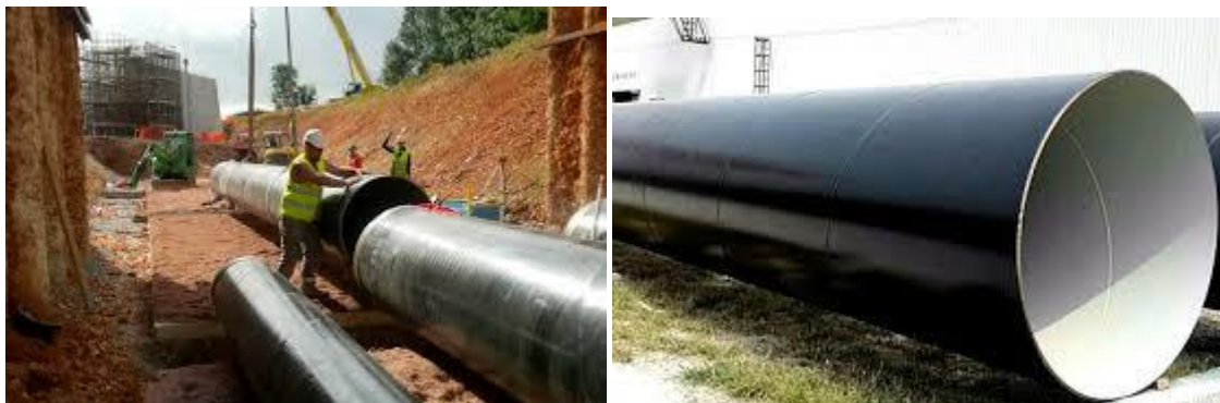
Figure (II.1) : conduite en acier
