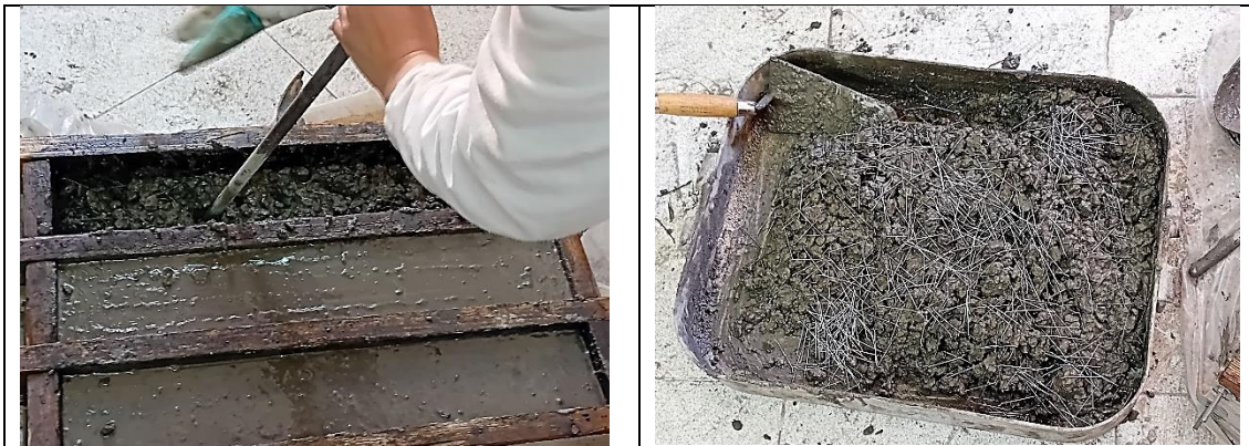
Figure III.24. Malaxage et vibration de béton fibré
