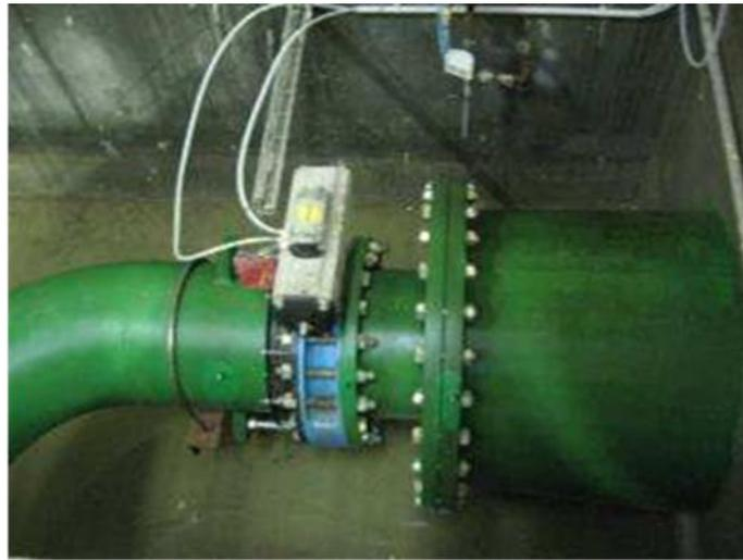
**Figure II.10:** Vanne pneumatique d'entrée d'eau de lavage
