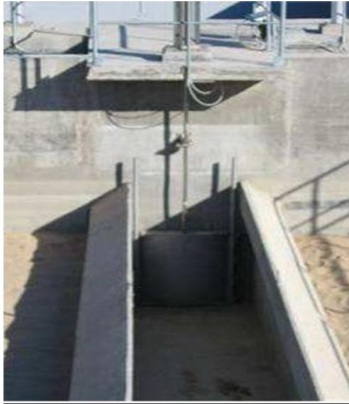
**Figure II.9 :** Vanne de sortie d'eau sale de lavage
