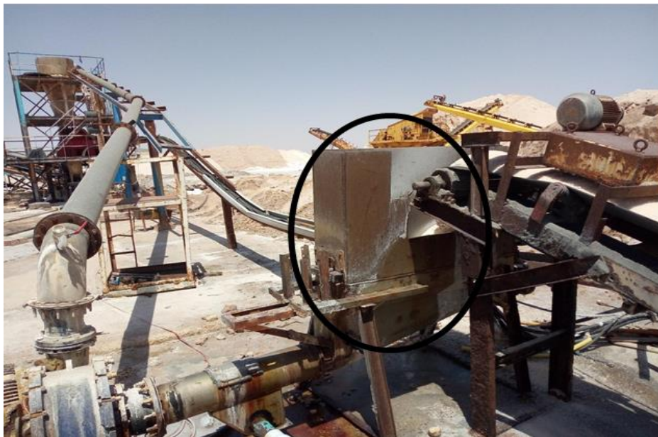
Figure7 : Station de lavage (bac de mélange)
