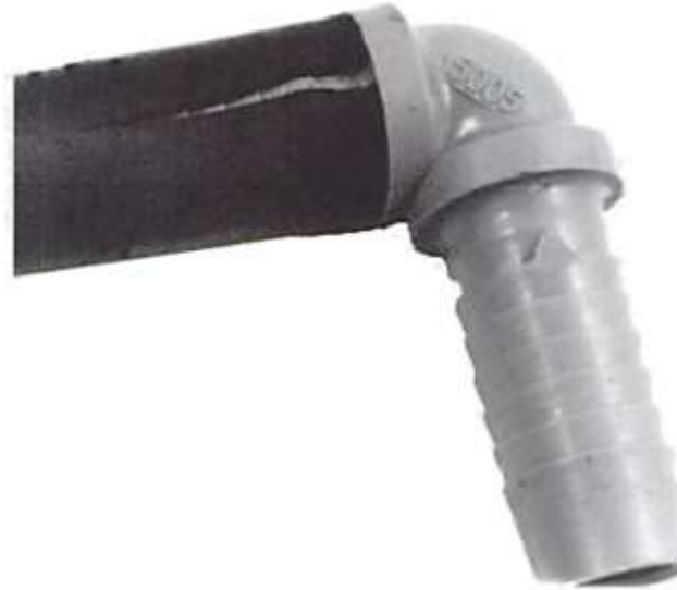
Figure V.1 – Fissuration sous contrainte en milieu tensioactif d'un tuyau de polyéthylène.
