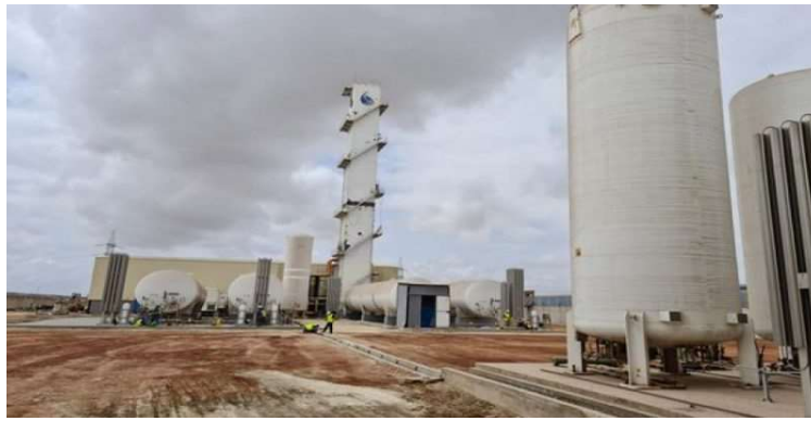
Figure. I.2 : L'unité de séparation de l'air à Rayanox.
