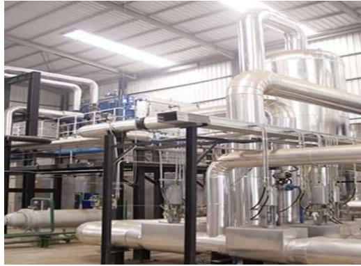
Figure I.3 : canalisations du dioxygène médical.
