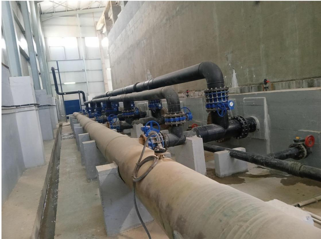
**Figure 28 :** l'alimentation des sous bassin de la calcite en eau déstalinisé +co2 dissoute
