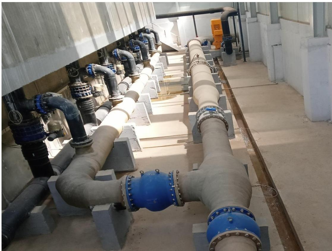
**Figure 29 :** la sortie d'eau reminéralisée vers le réservoir d'eau traité
