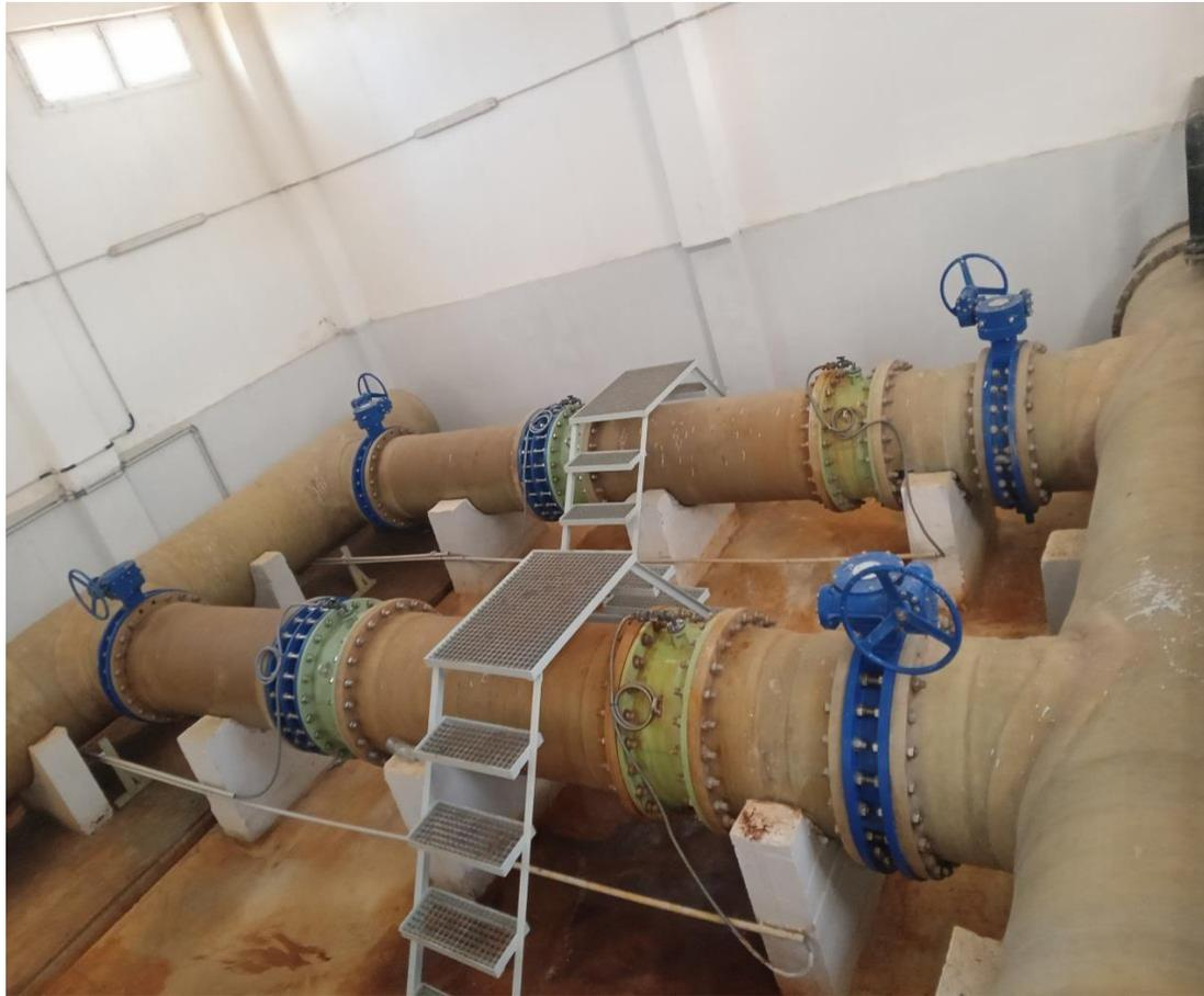
**Figure 08 :** les conduites d'injections des produits chimiques.
