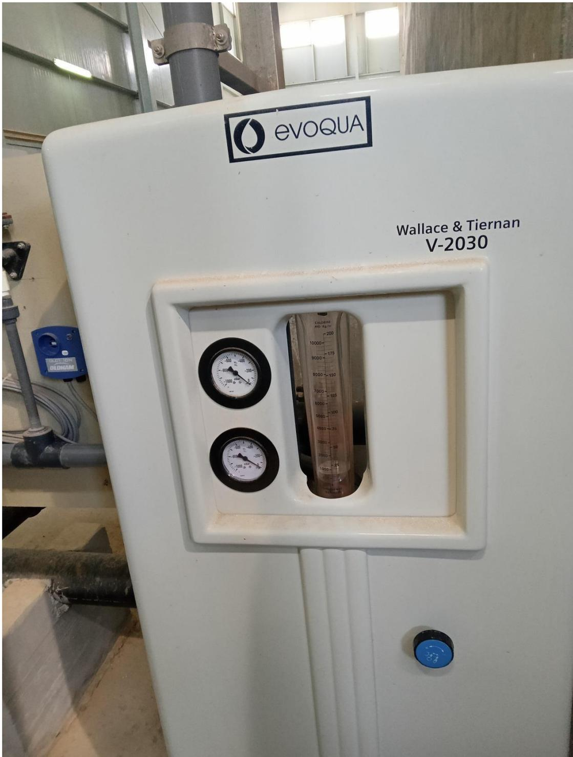
**Figure 26:** la machine qui injecte le  $\text{CO}_2$  dans le mélangeur.
