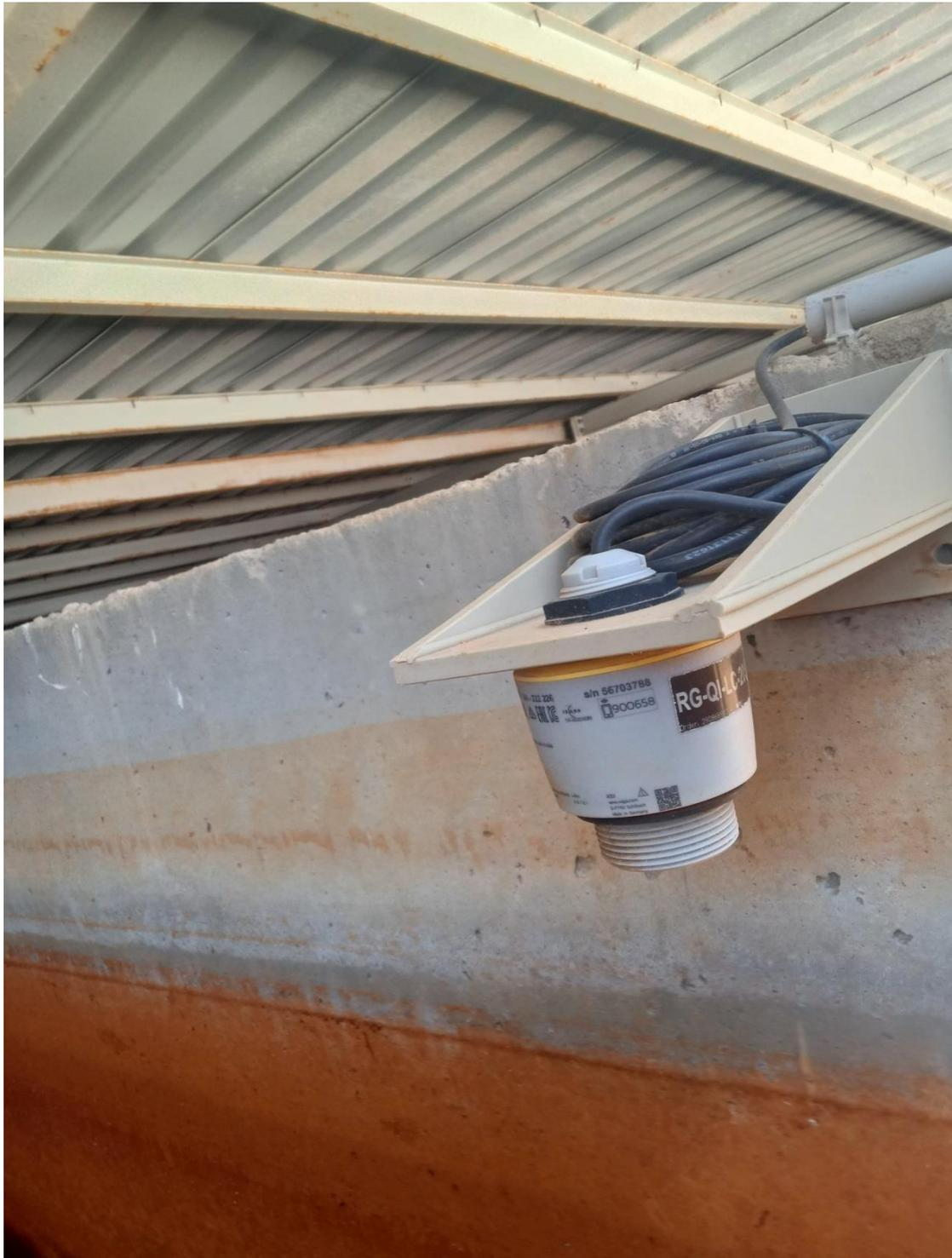
**Figure 31** : radar indicateur de niveau d'eau dans chaque bassin.
