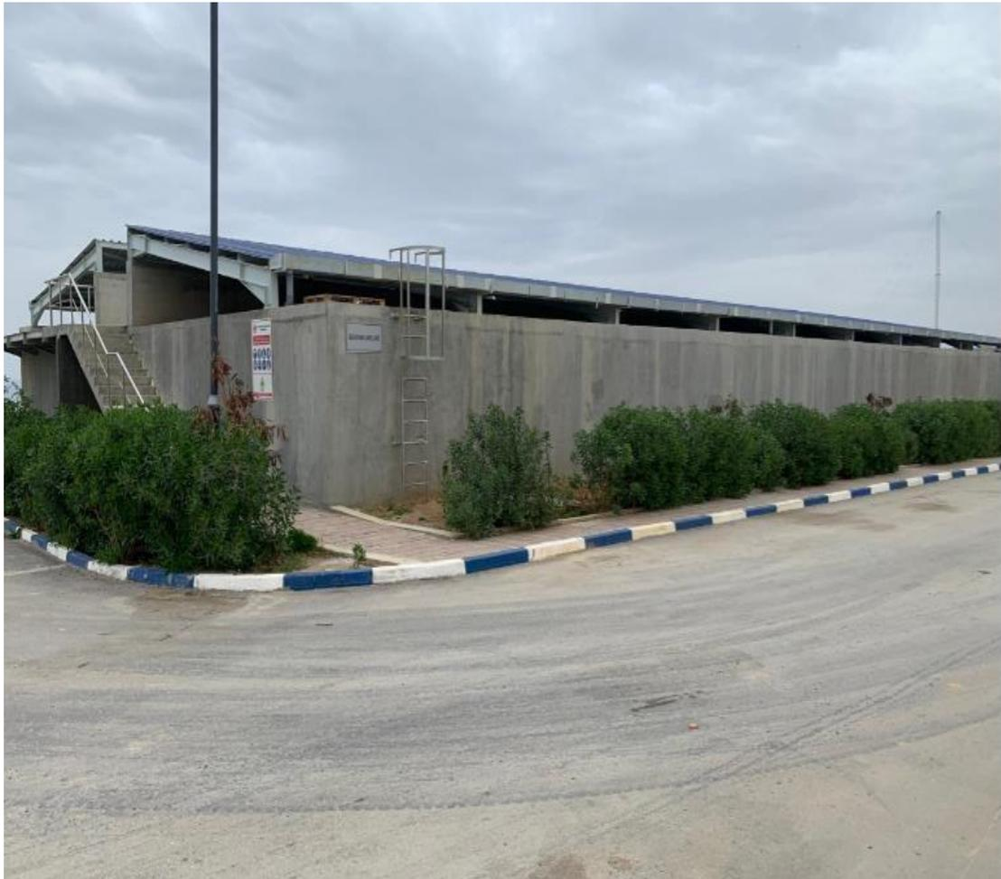
**Figure 11** : le bassin de décantation lamellaire.
