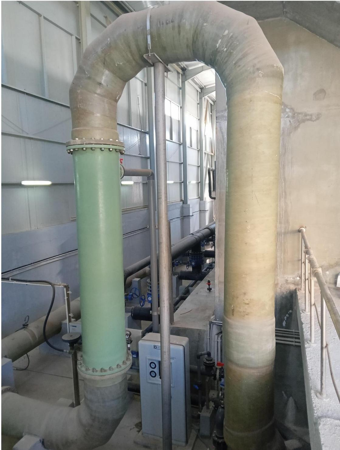
**Figure 27:** le mélange d'eau déstalinisé avec le  $\text{CO}_2$  dans la conduite verte qui diminue le pH d'eau pour faire dissoudre la calcite qui se trouve en haut.
