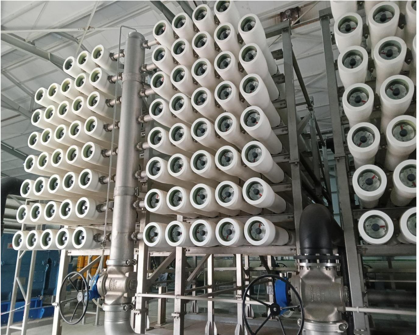
**Figure 17** : un rack équipé d'un ensemble de membrane.
