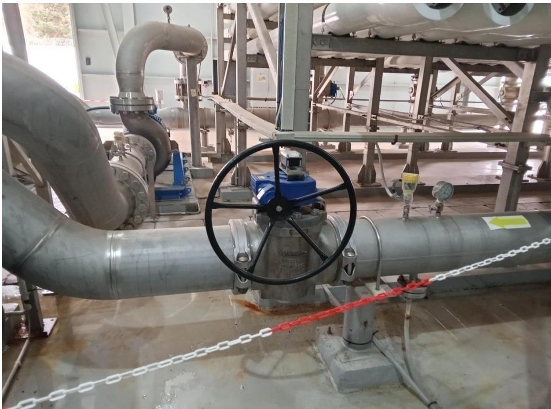
**Figure 22** : vanne pneumatique de saumure avant (ERD).
