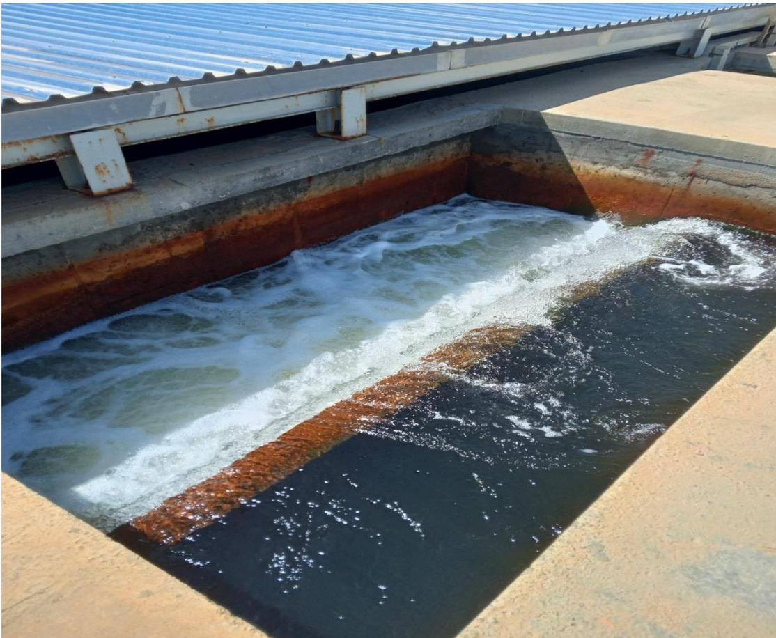
**Figure 13** : l'entrée du sous bassin du filtre à sable.
