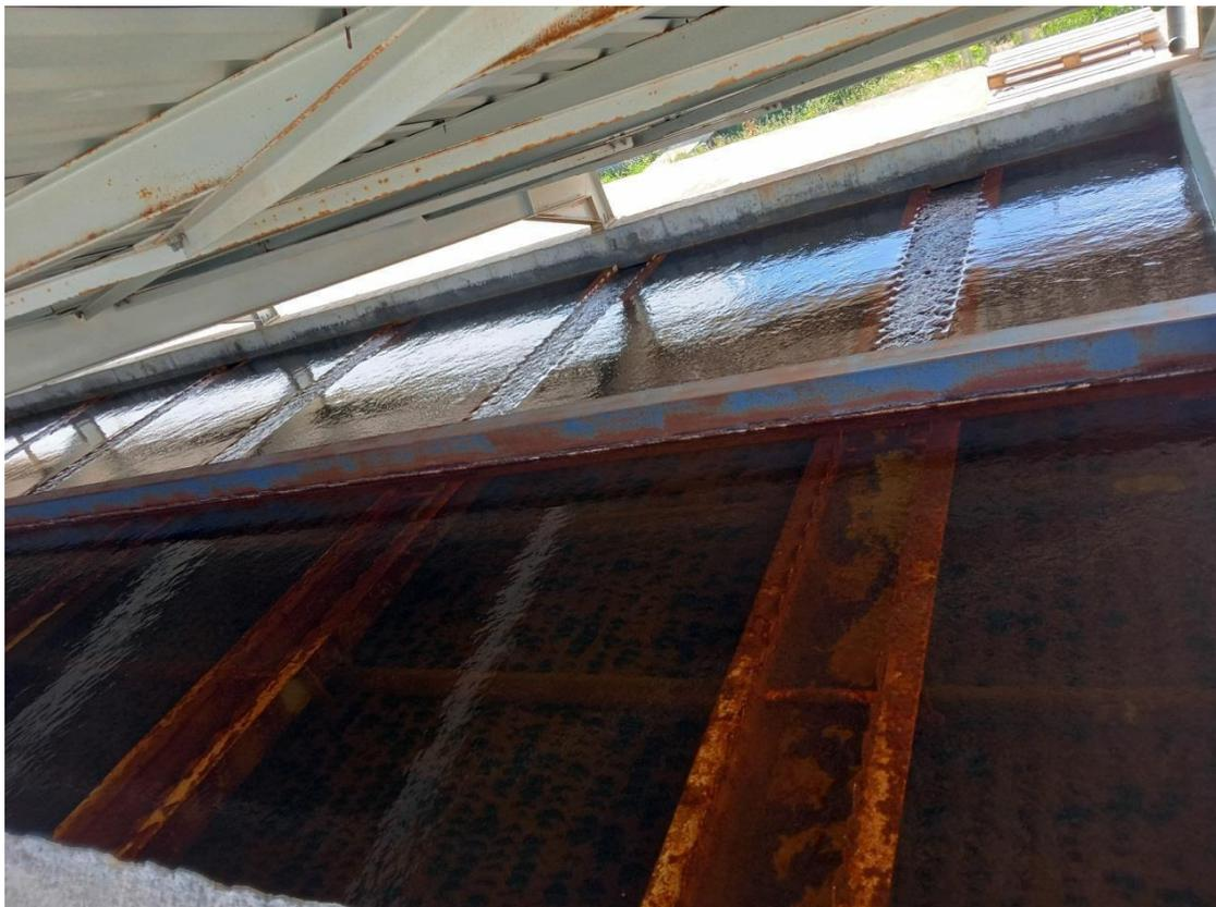
**Figure 10 :** un sous bassin de décantation lamellaire.
