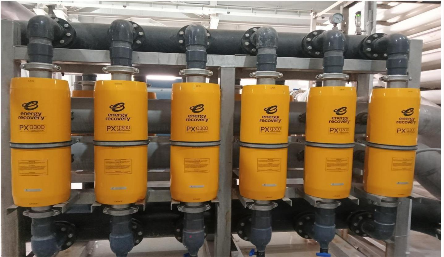
**Figure 18 :** le convertisseur de pression situé avant le rack (ERD).
