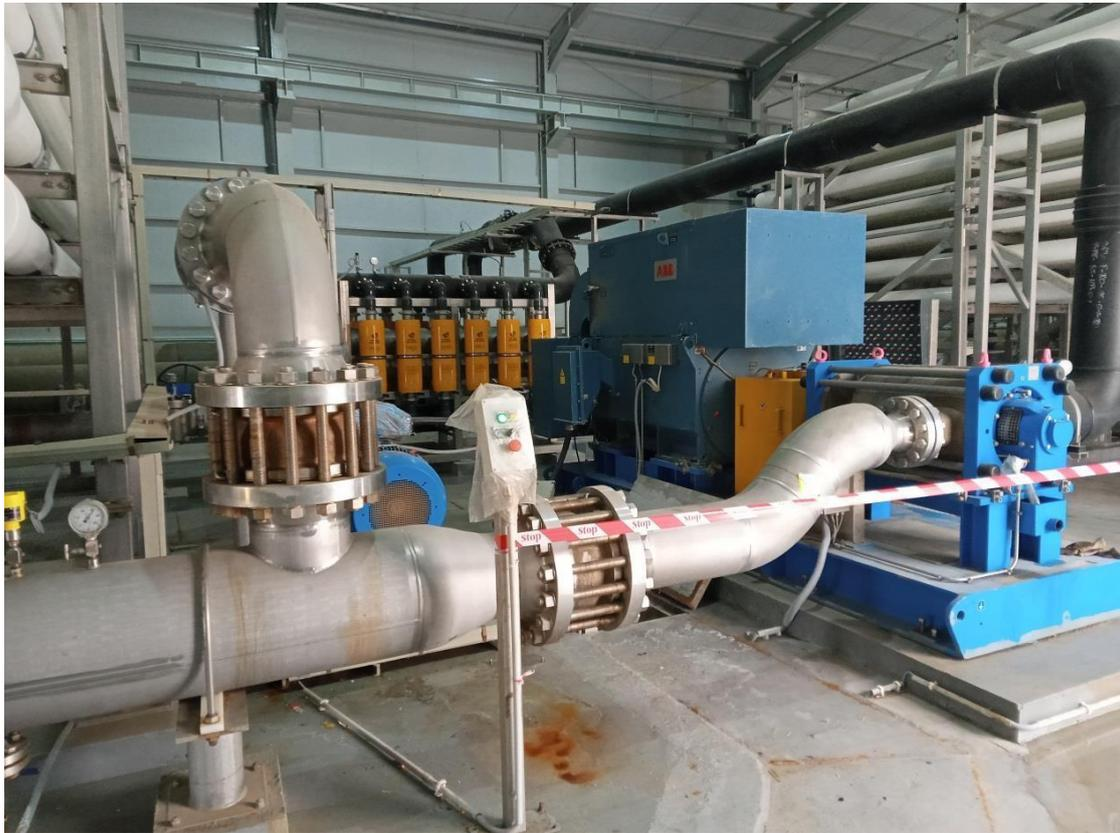
**Figure 21** : la pompe à haute pression (HP)
