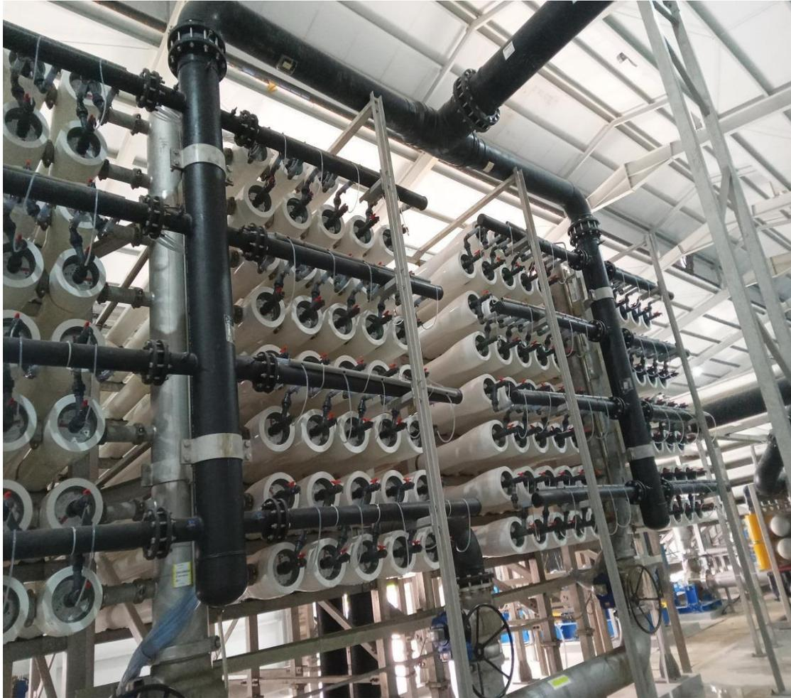
**Figure 20:** la sortie d'eau traité de la membrane en noir et la saumure en gris.
