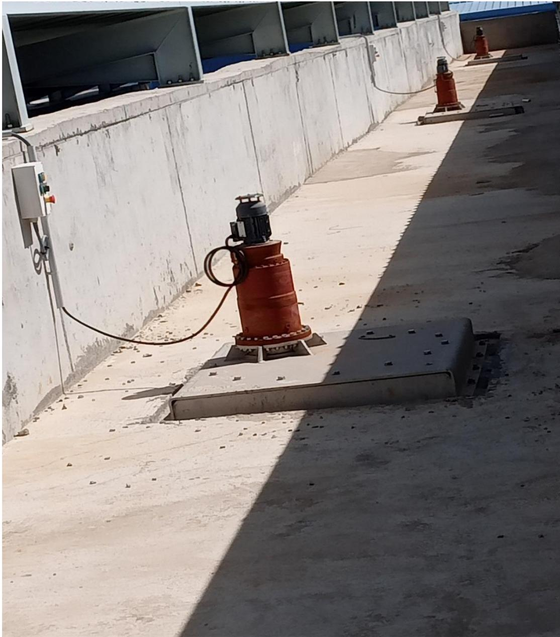
**Figure 12** : réducteur des agitateurs de floculation et de coagulation.
