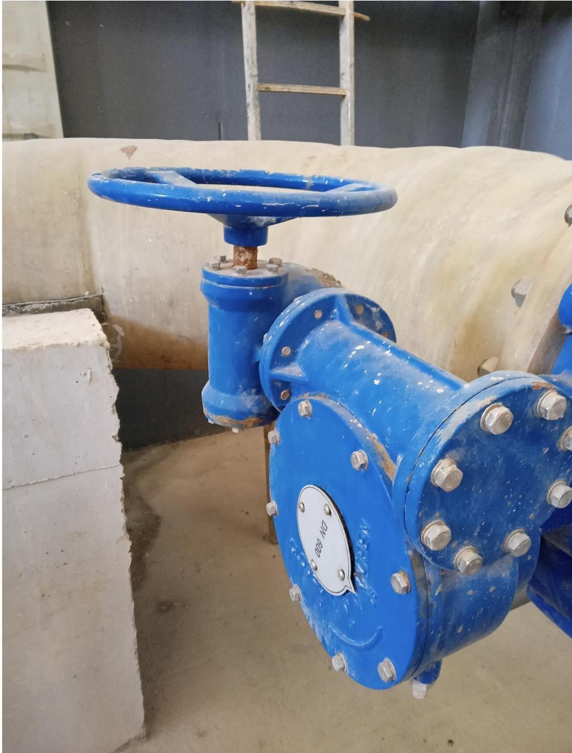
**Figure 16 :** vanne manuelle d'ouverture.
