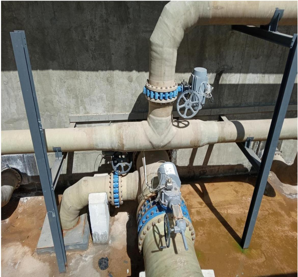
**Figure 15** : les différentes conduites branchées a la sortie du filtre a sable.
