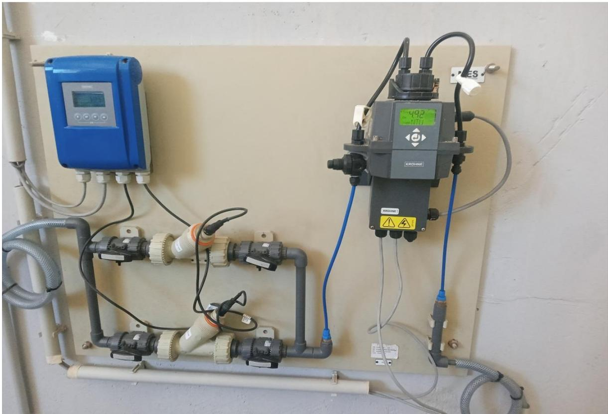
**Figure 30 :** ph mètre en noir et un multimètre qui affiche (débit,température,turbidité).
