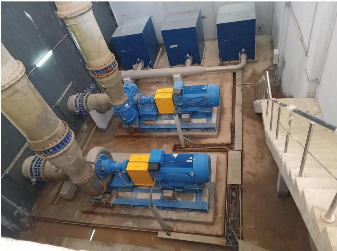
**Figure 25:** les pompes de lavage contre-courant avec des suppresseurs.
