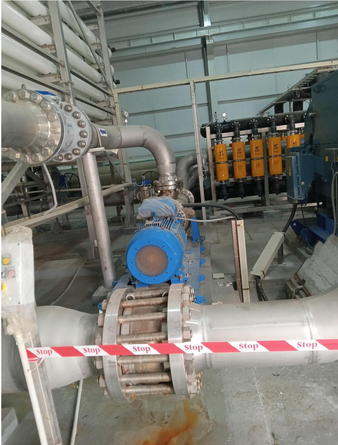
**Figure 23 :** la pompe booster placé avant le rack des membranes
