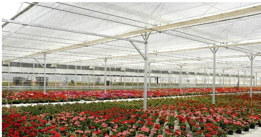
Figure1- 13: Image du système de refroidissement par écran [15]
