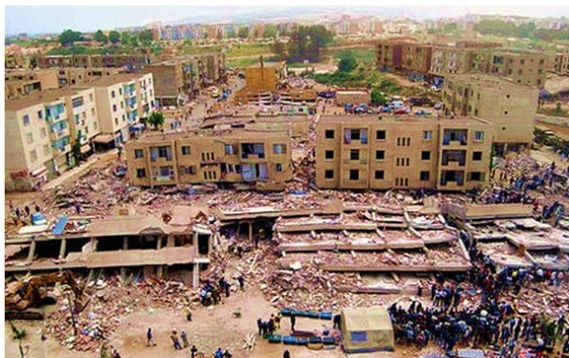
Figure I.4 : Effondrement des bâtiments dans le séisme de Boumerdès 2003 (Kebaili, 2009)
