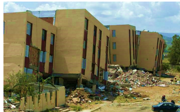
Figure I.4 : Effondrement des bâtiments dans le séisme de Boumerdès 2003 (Kebaili, 2009)
