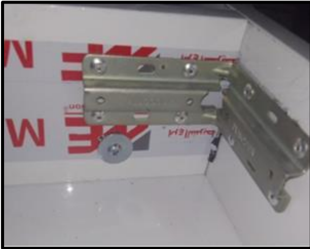
Figure 3. 8 : Les pattes de fixation.
