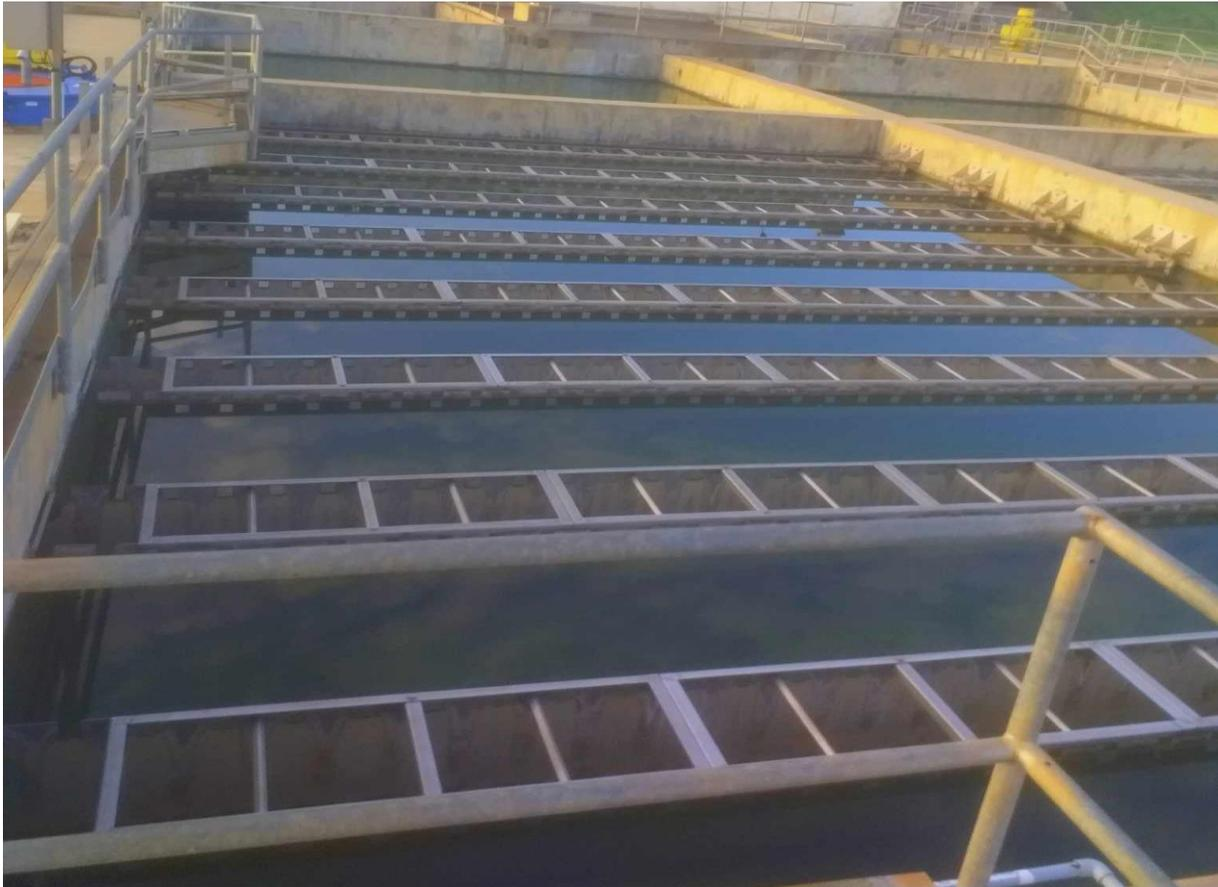
Figure III 9: L'ouvrage de décantation lamellaire.
