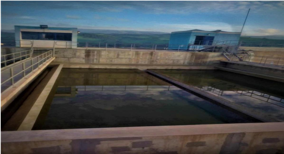
Figure III 11: L'ouvrage de filtration sur sable (2cellules/ AQUAZUR V)
