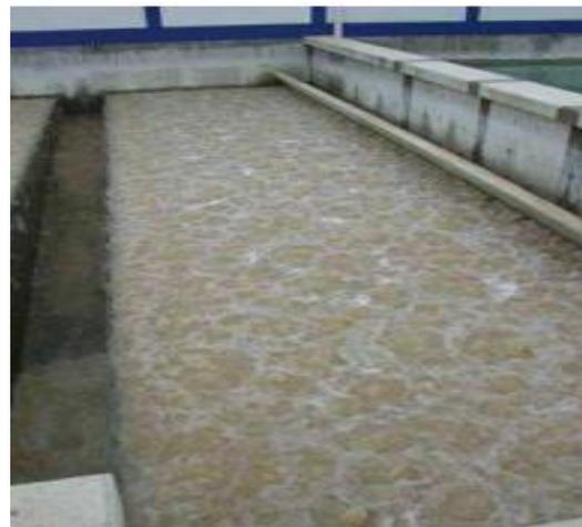
Figure III 15: Le filtre en lavage à l'eau et l'air
