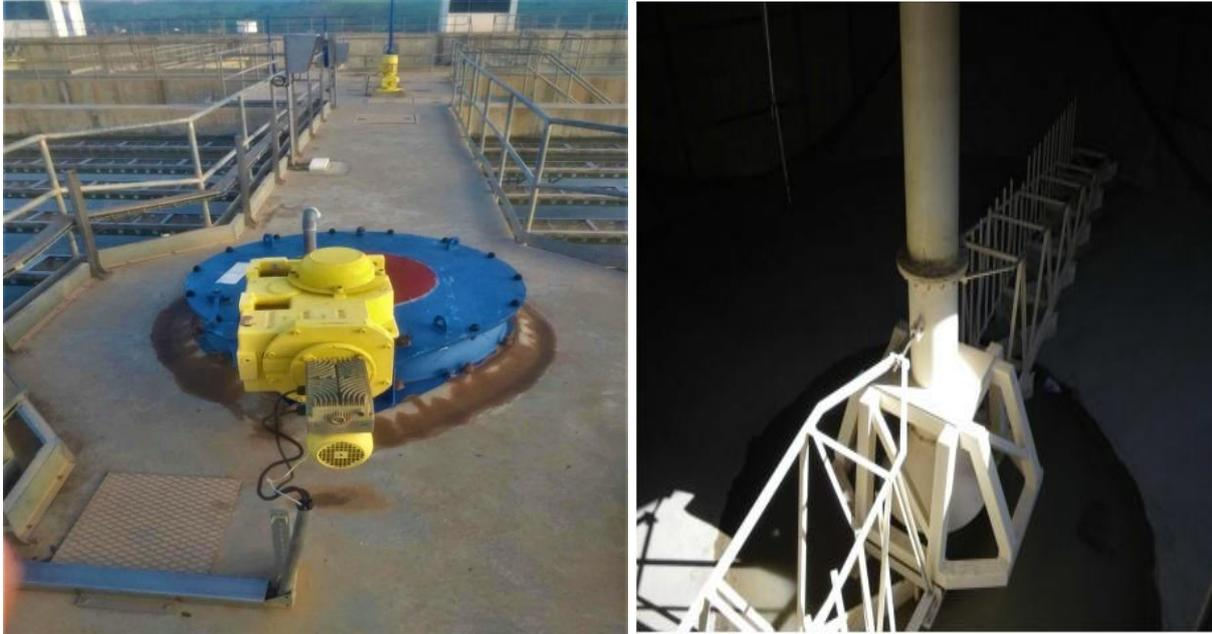
Figure III 8: Moteur et tête de l'agitateur de décantation et le racleur avec les lames.
