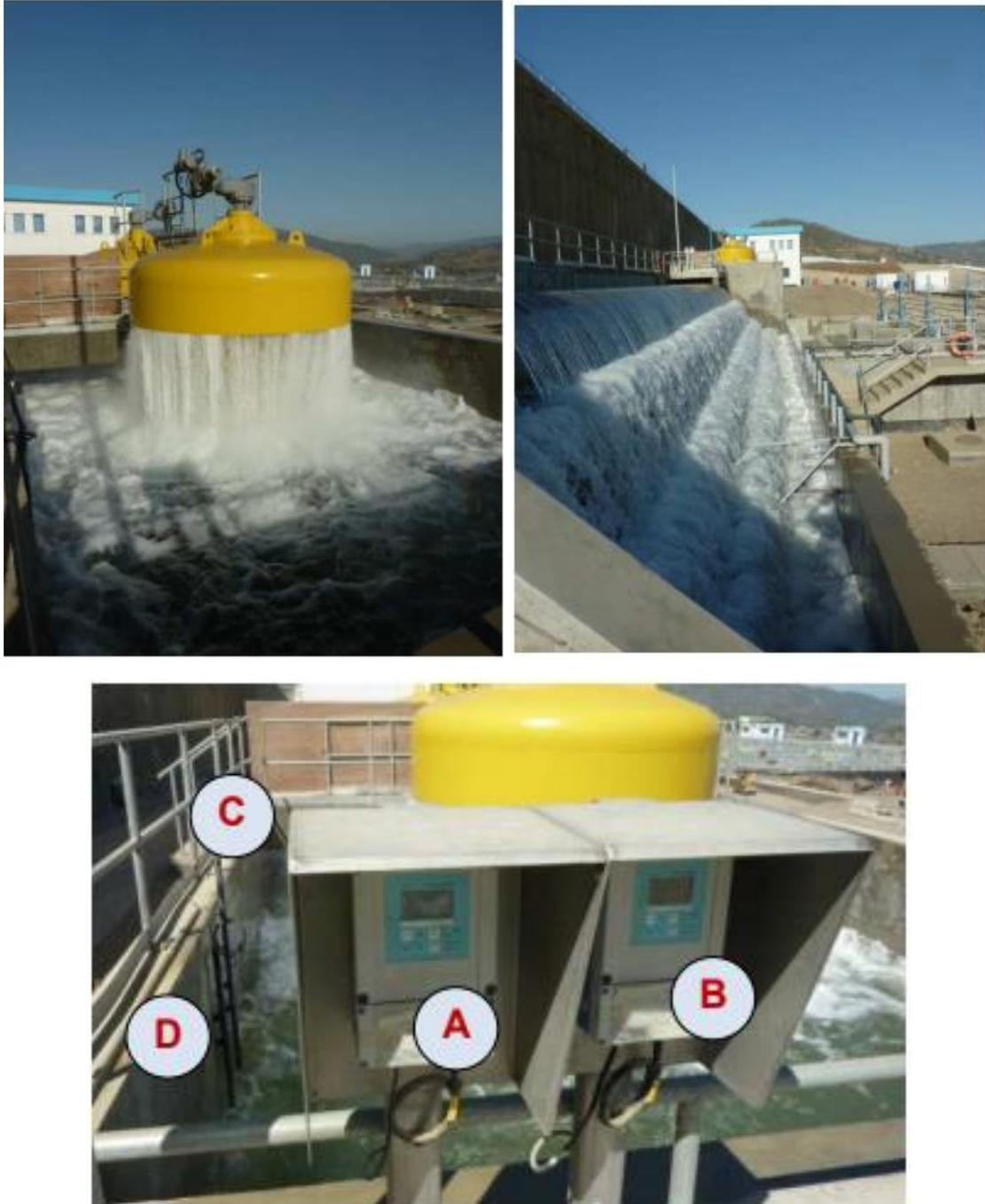
Figure III-3: Equipements et instruments impliqués à l'ouvrage d'entrée.
