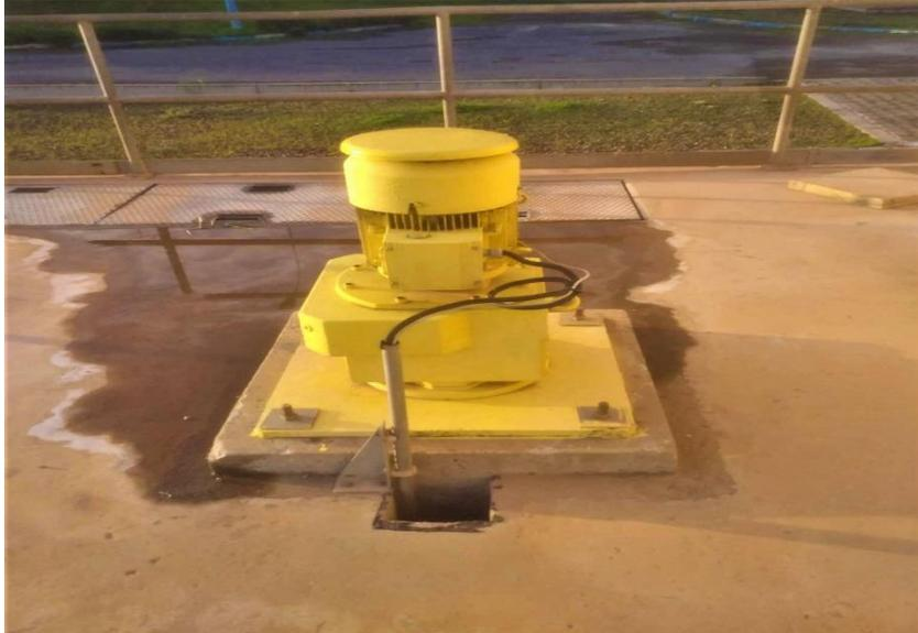
Figure III 6: Moteur agitateur zone de coagulation
