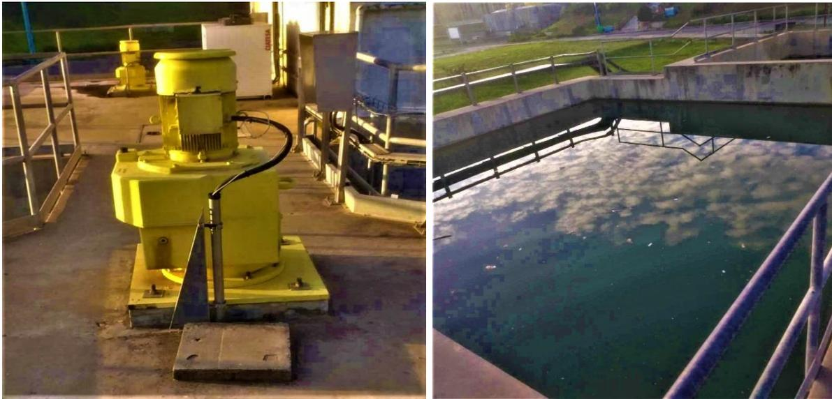
Figure III 7: Moteur agitateur et chambre de mélange zone de floculation.
