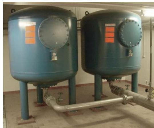
Figure (III. 8) : Réservoir à vessie.
