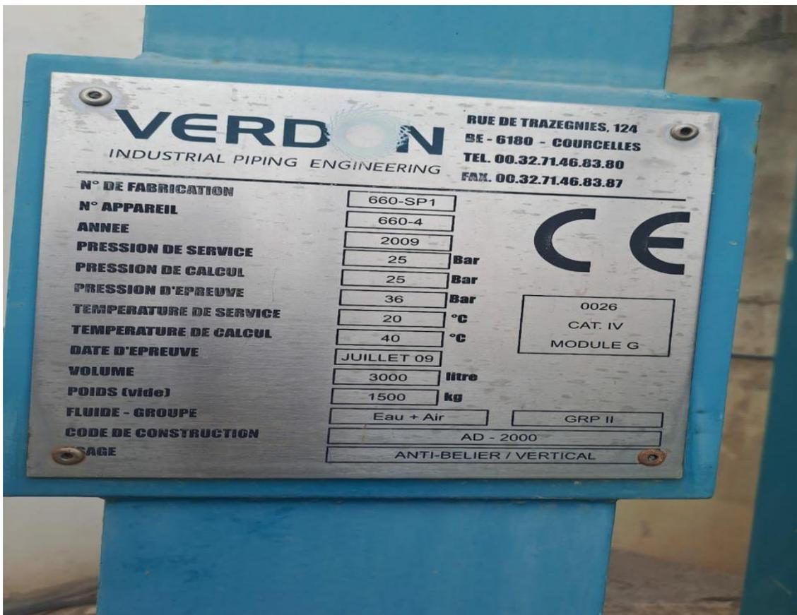
Figure (V. 12) : Fiche technique de réservoir anti-béliier.
