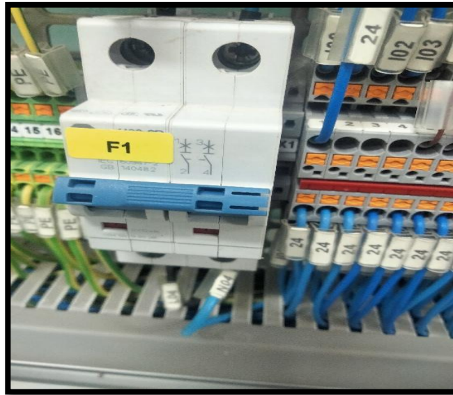
FIGURE VI. 18: DISJONCTEUR BIPOLAIRE.
