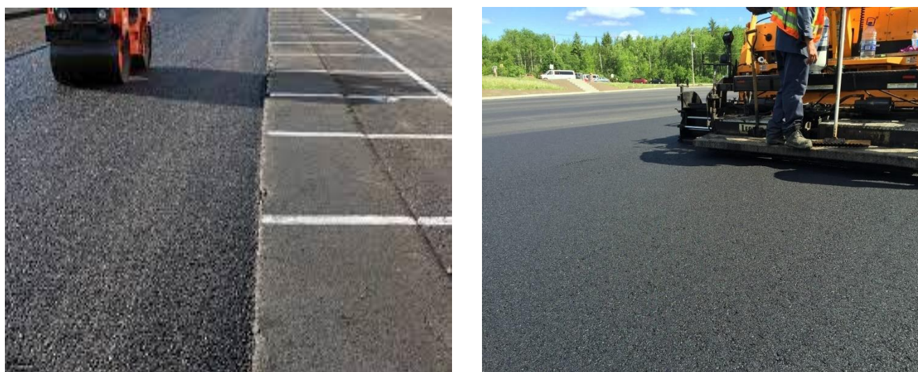
Figure II 20: Technique de l'asphalte caoutchouté
