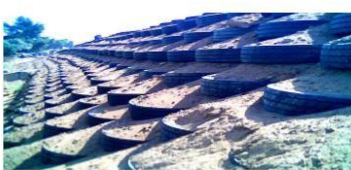
Figure II 15: Pose des nappes de pneus Projet pilote – Route de Bou Smail.
