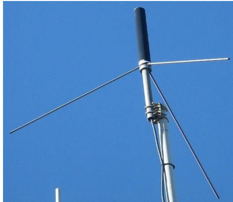
Figure 2.10 : L'antenne VHF de la tour
