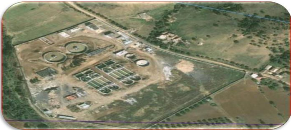
Figure 23 : Image de la station par Google earth.
