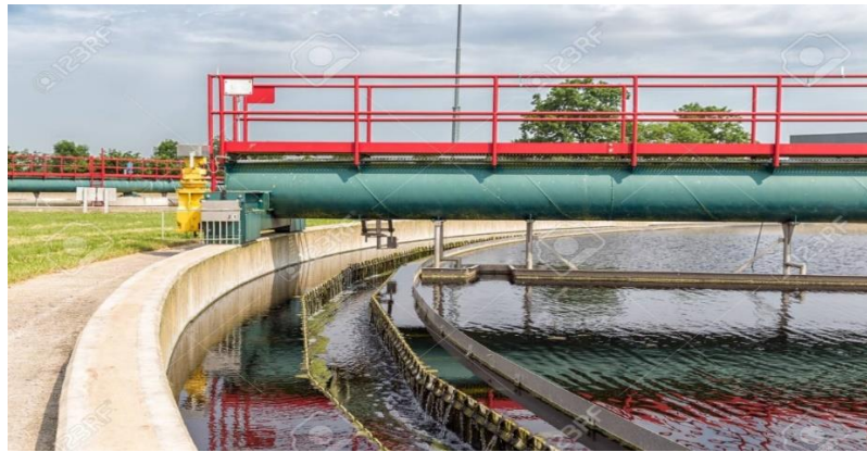
Figure12 :Cuve de décontation
