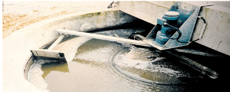
Figure 10 : Dégraissage et déshuilage
