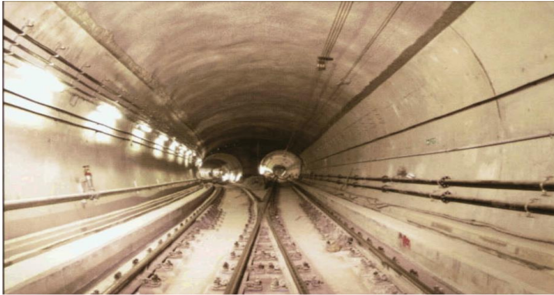
Figure 1. 11 Métro de Stockholm avec revêtements permanents en béton projeté renforcé en fibres d'acier [53].
