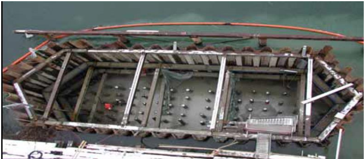
Figure 1. 12 Béton sous-marin renforcé d'acier [55].
