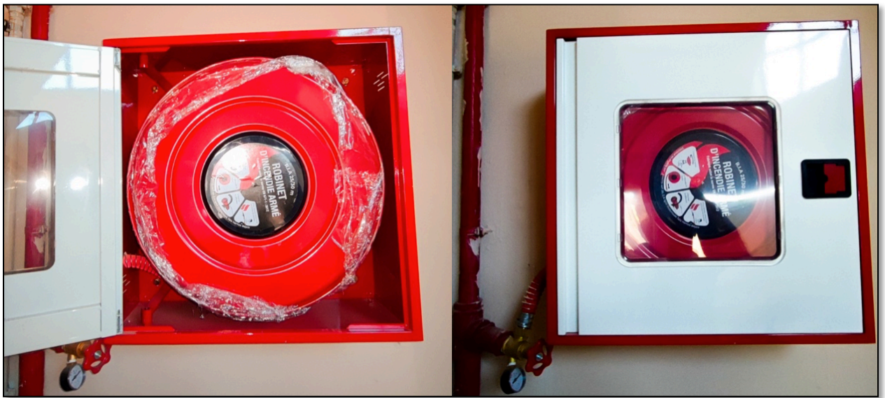
FIGURE I-17 : ROBINET D'INCENDIE ARMÉ (R.I.A.)
