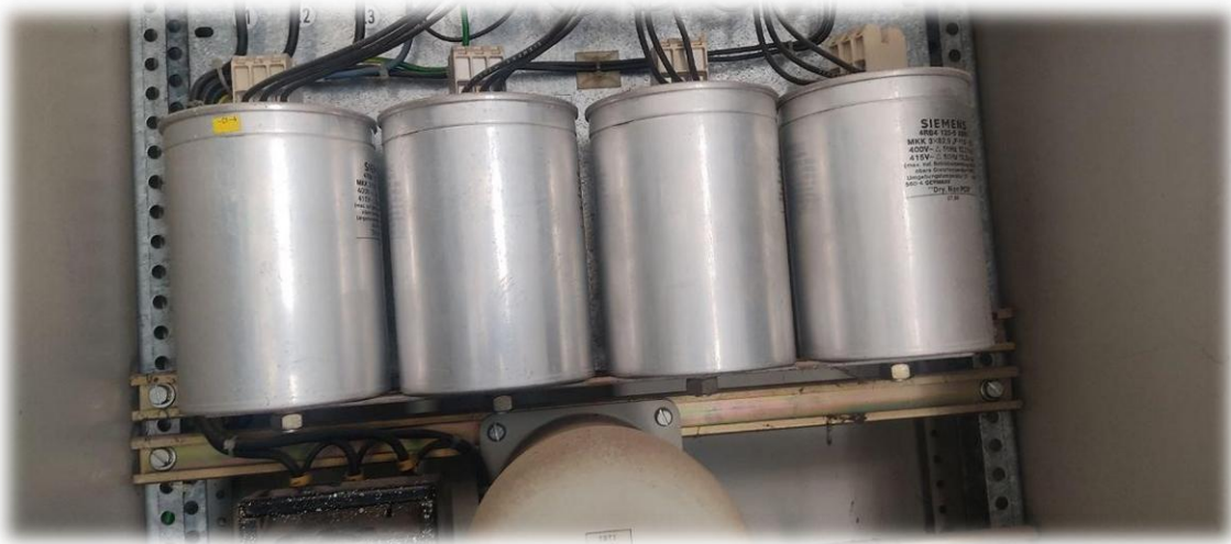
Figure 2.4. Banque de condensateurs pour correction du facteur de puissance.
