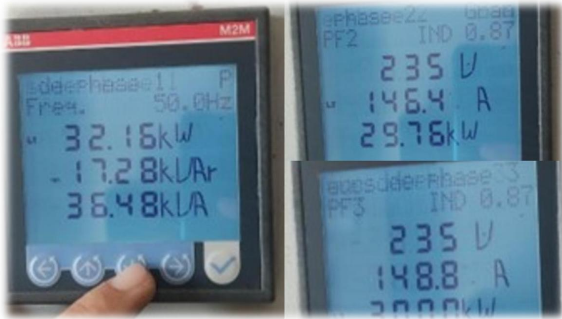
Figure2.3: Relevés de surveillance de puissance triphasée.
