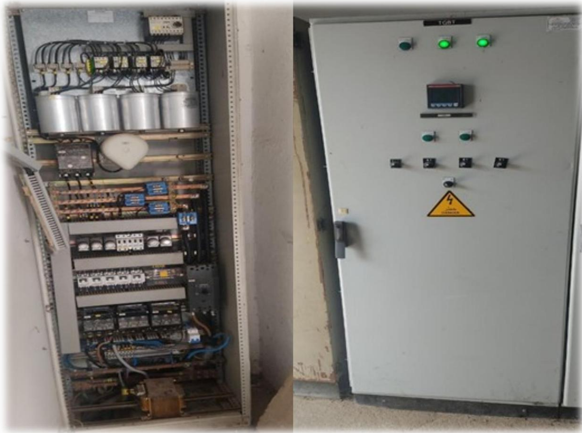
Figure 2.2: Les armoires de compensation existantes au centre Sidi Arcine CV165.
