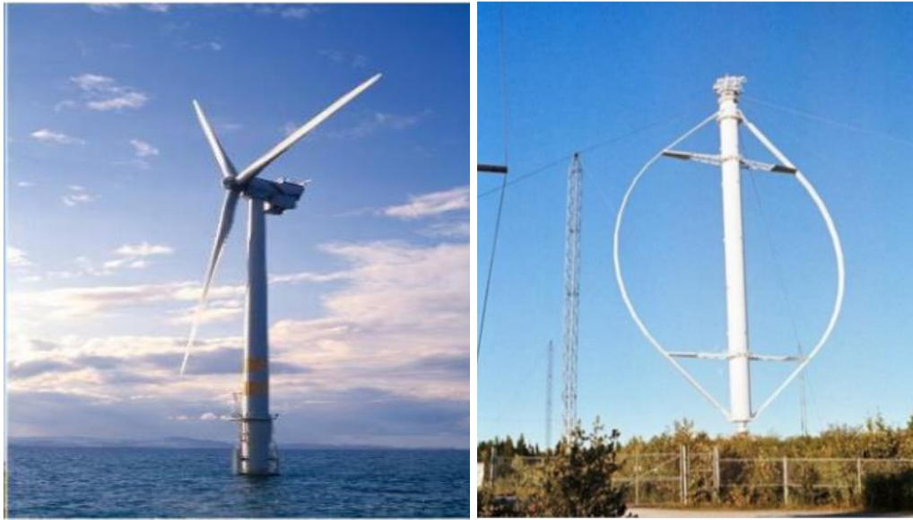
Figure.1.2. Eolienne à axe horizontal et à axe verticale[13]
