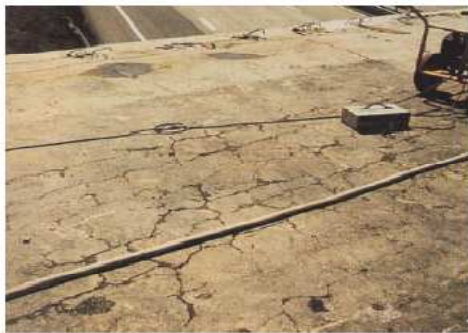
(a) Tablier d'un pont
