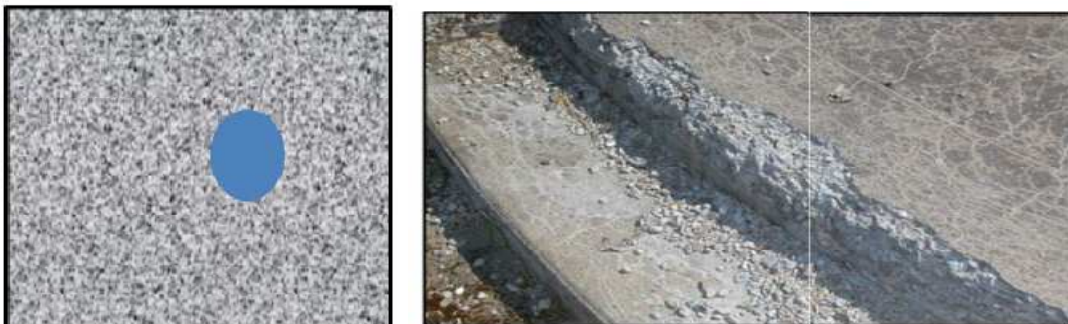
Figure II.7. Actions des sels de déverglaçage [22].
