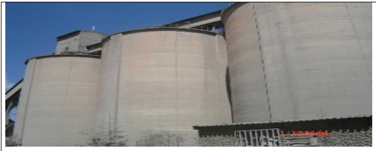
Figure I.9 : Transport et stockage du clinker après refroidissement
