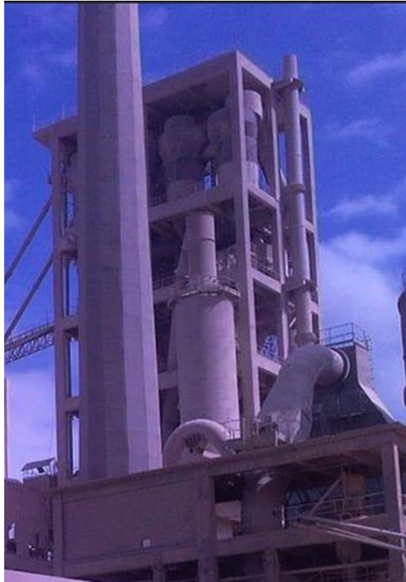
. Figure I.5 : Extraction de la farine crue et alimentation du four
