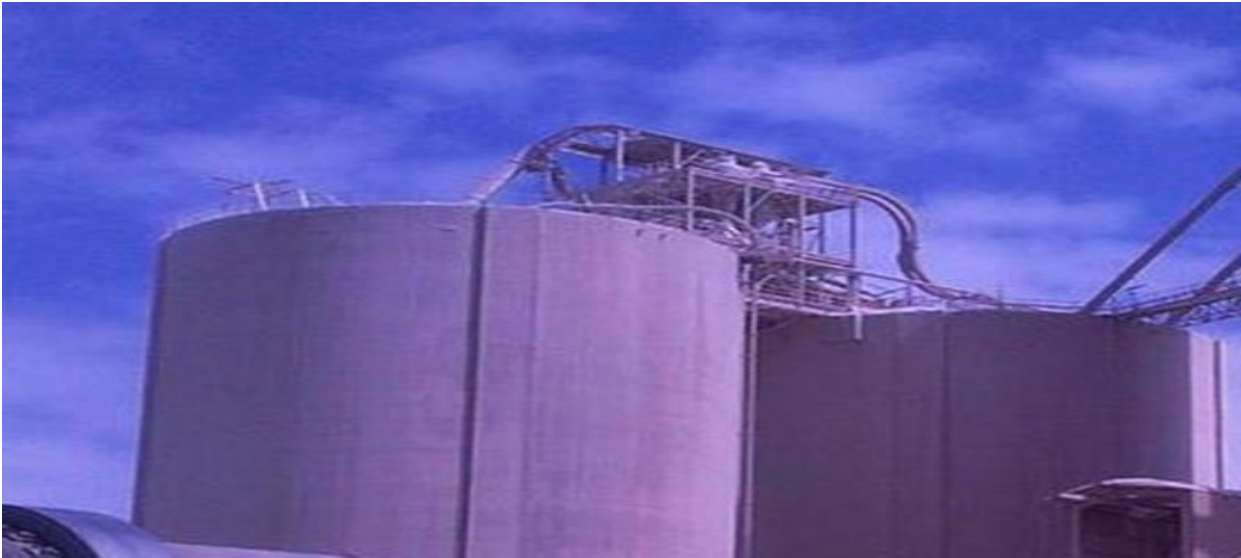
Figure I.4 : Transport de la farine crue vers les silos d'homogénéisation
