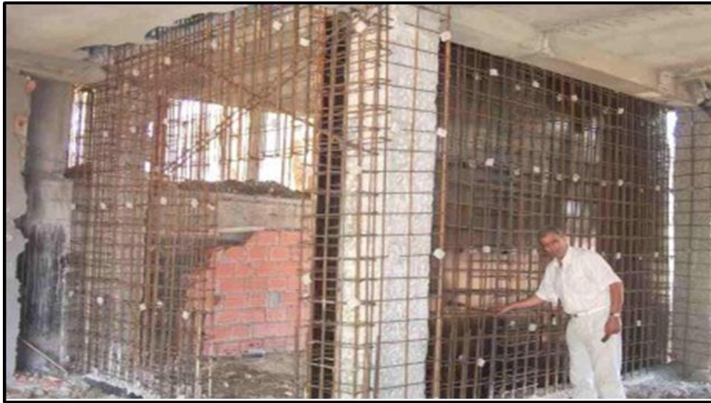
Figure I.20 : Rénovation d'un bâtiment existant après le séisme de Boumerdes par l'ajout de murs de cisaillement.
