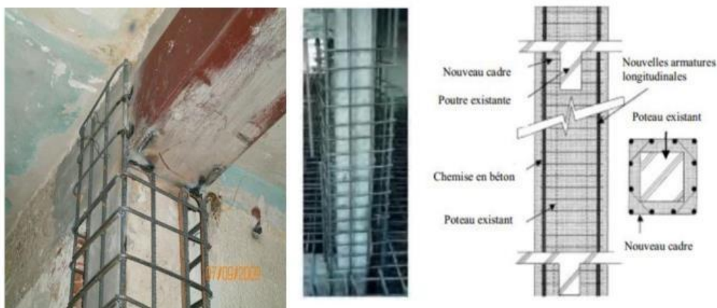
Figure I.21: chemisage d'un élément dans une structure.
