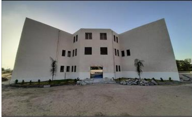
Figure I.10: Collège en construction (système de murs en béton armé).
