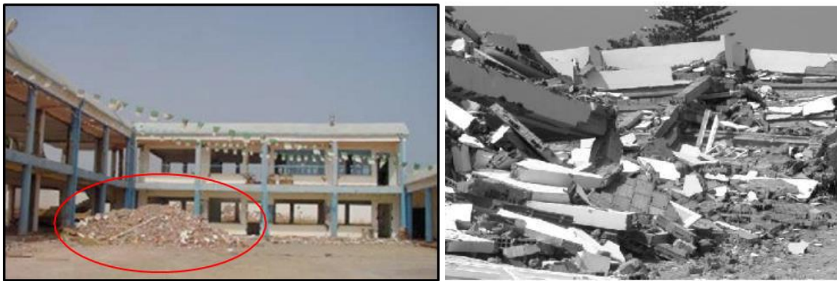
Figure I.12 : Effondrement de bâtiments auto stables en maçonnerie.
