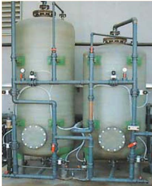
Figure I.6: Installation d'une série des colonnes sous pression
