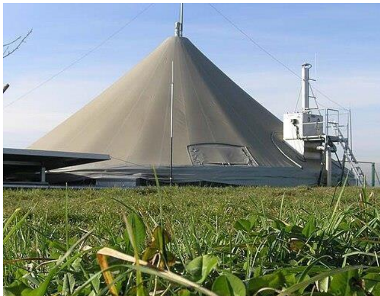
Figure I.10 : Unité de stockage de l'usine de biogaz de Güssing (Burgenland, Autriche). 20
