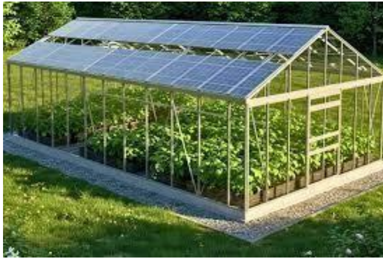
Figure I.9 : Des panneaux solaires sur la serre. 16
