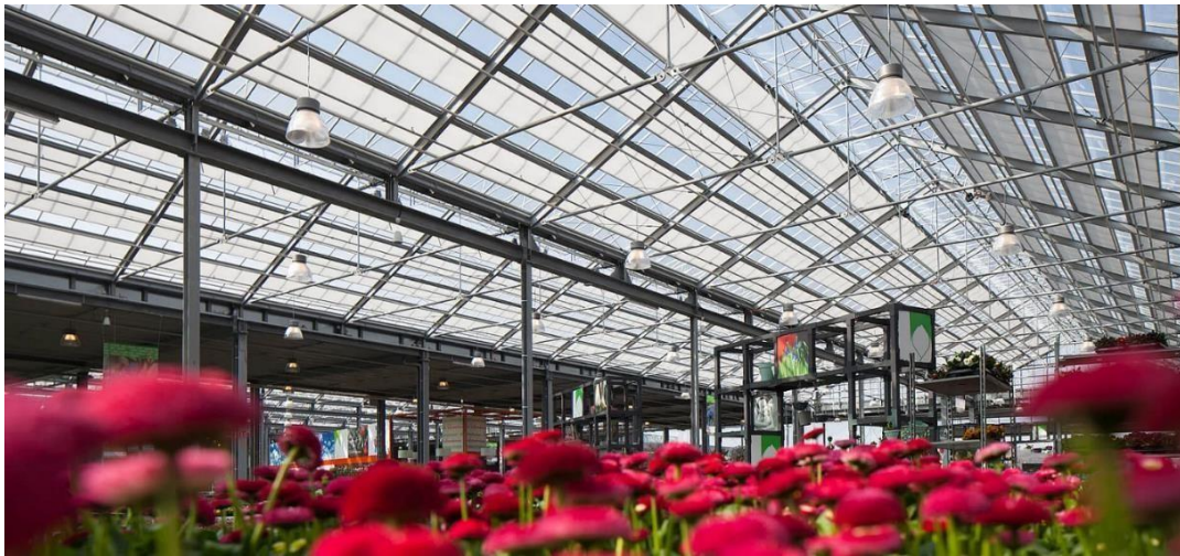
Figure I.8 : Système d'ombrage pour une serre. 15
