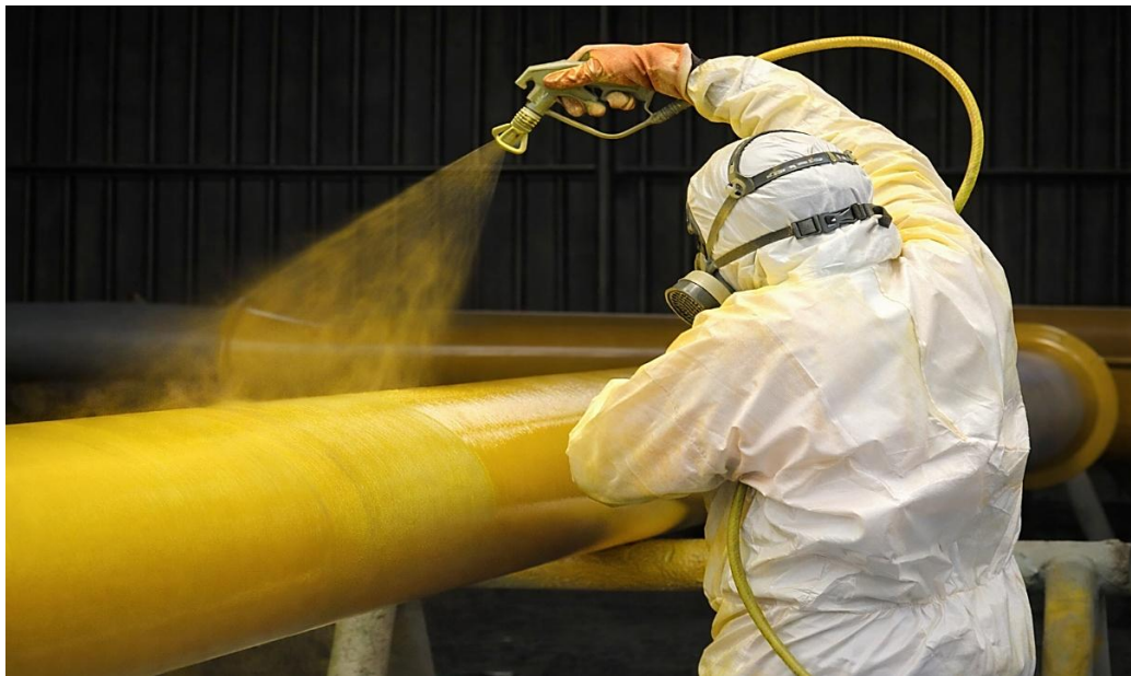
Figure I.11 : Application d'un revêtement protecteur.
