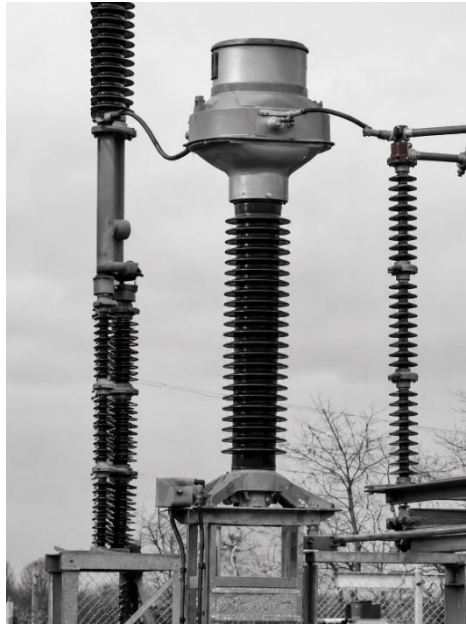
Figure I.9 : Transformateur de courant (TC).
