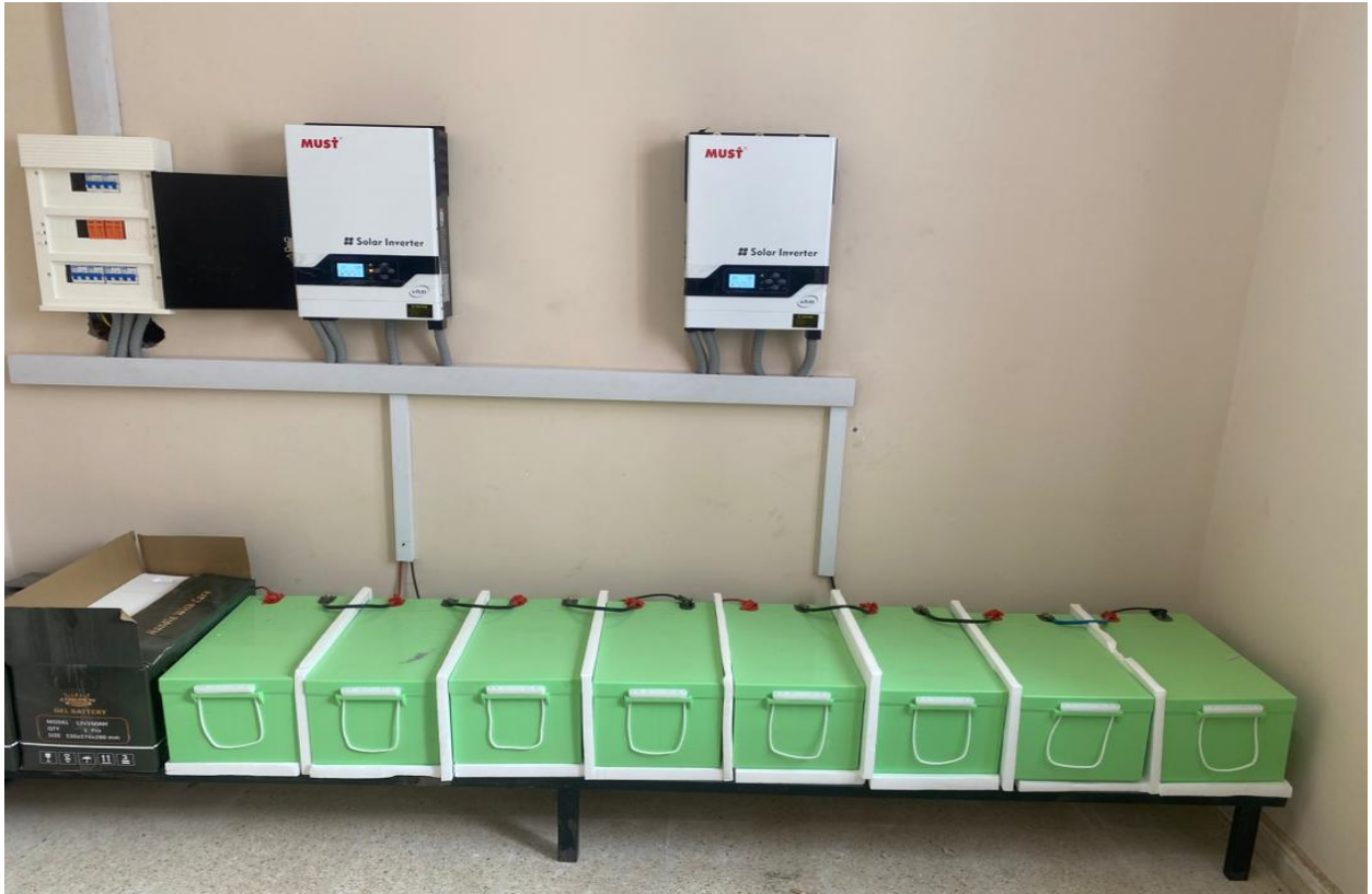
Figure 2.7: Parc des batteries
