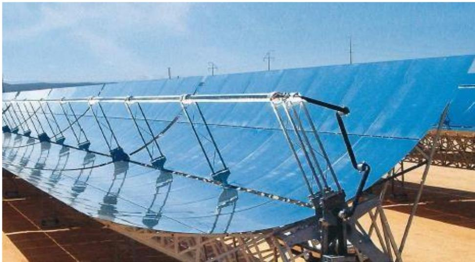
**Figure (II.14) :** Capteur cylindro-parabolique.
