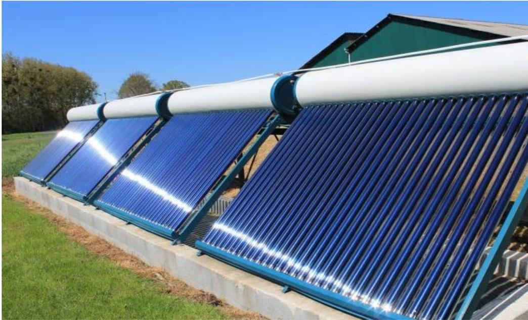
**Figure (II.3) :** Capteur solaire thermique
