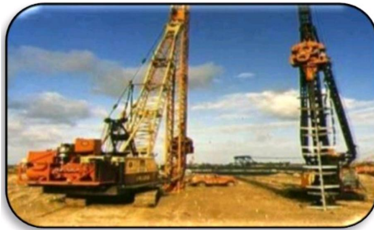
Figure II.2 : Compactage par vitro-sonde. [49]
