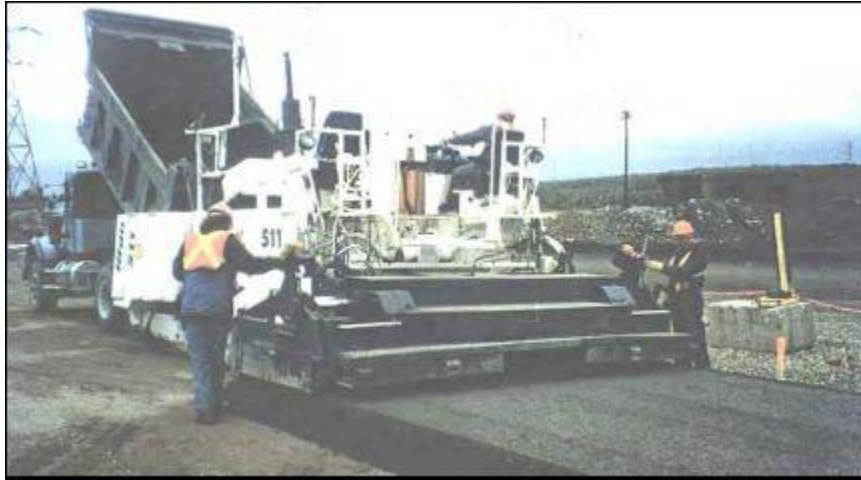
Figure I.19 : finisseur à haut pouvoir de compactage. [19]
