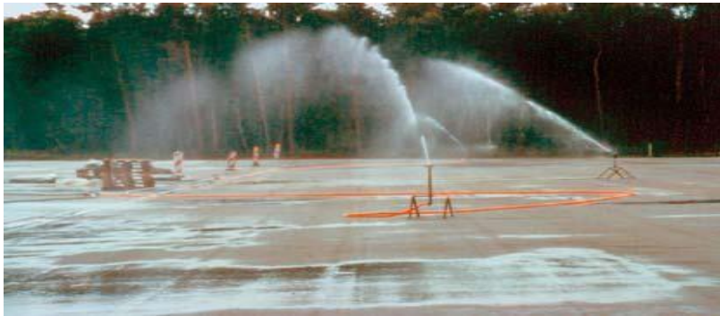
Figure I.6 : Cure du béton par arrosages ciblés. [10]
