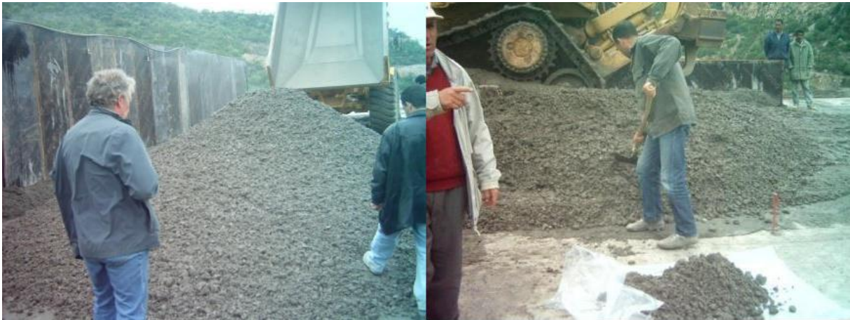
Figure I.8 : Etat du BCR frais lors de son déversement (Barrage Errmil Tunisie) [12].
