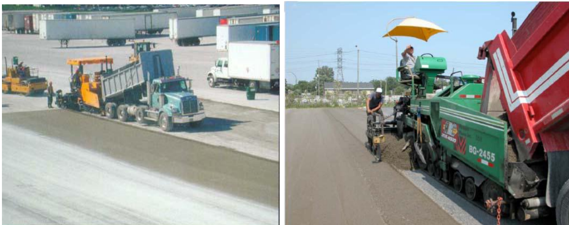
Figure III.2 : Transport et mise en place du BCR par finisseur à haut pouvoir de compactage [58]
