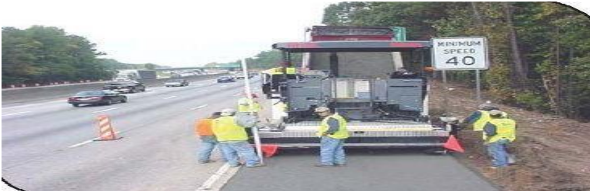
Figure I.12 : Mise en place du BCR en pavage, Atlanta a USA. [14]
