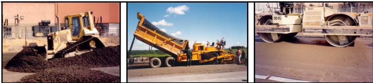
Figure I.2 : Equipement du compactage du BCR. [5]
