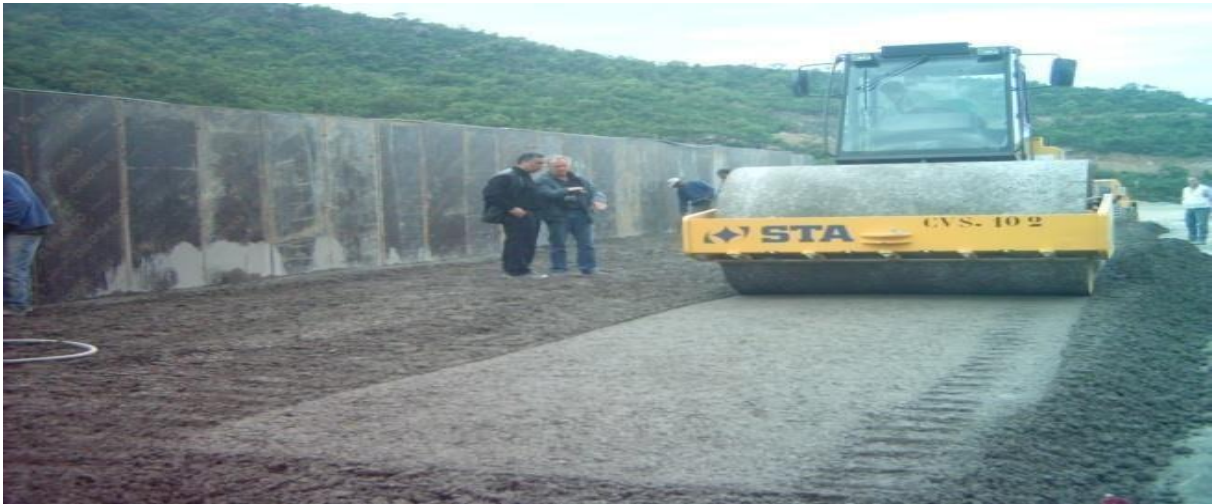
Figure I.9 : Compactage du BCR (Barrage en BCR Errmil - Tunisie). [12]
