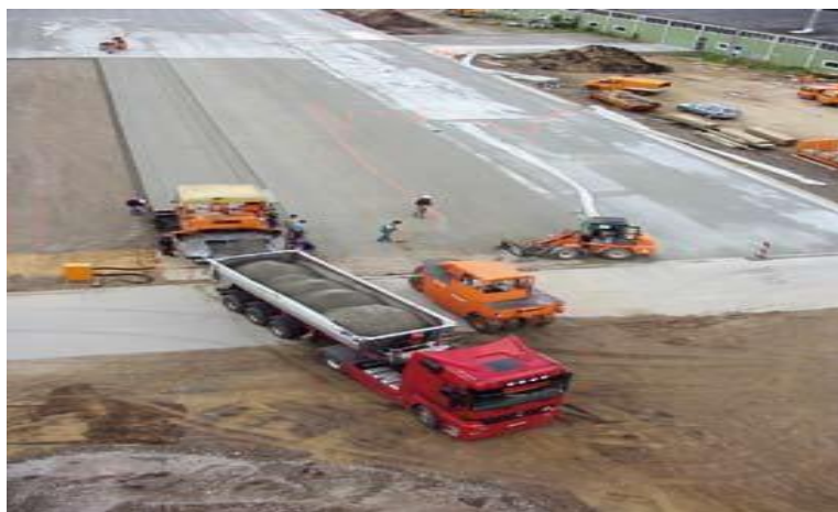
Figure I.5 : Mise en place de BCR par bandes. [9]
