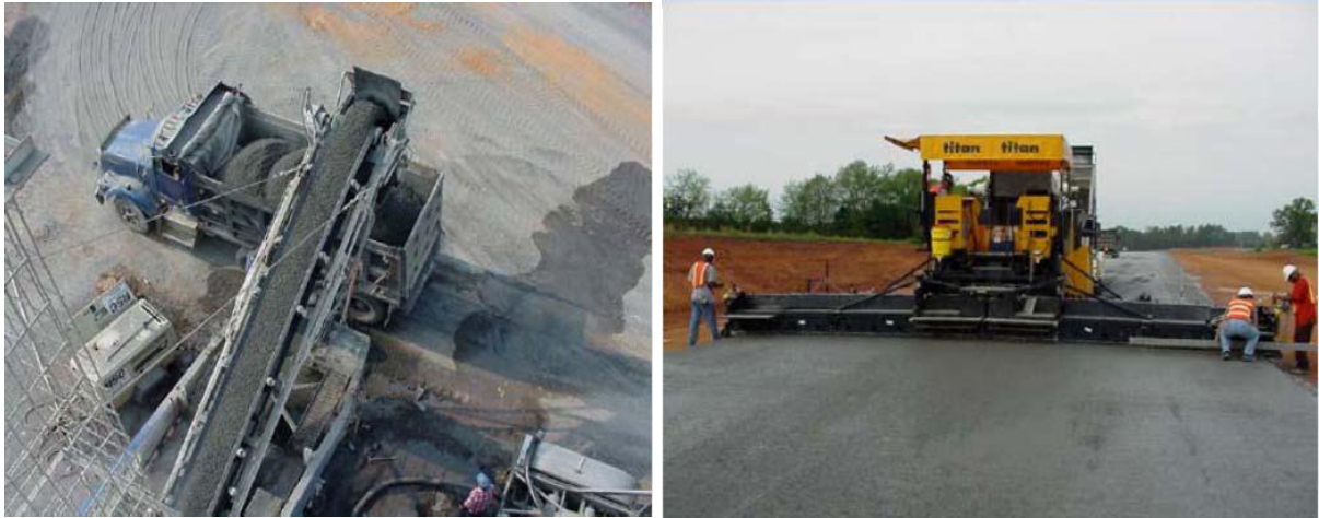
Figure III.1: Production et malaxage du BCR [58]
