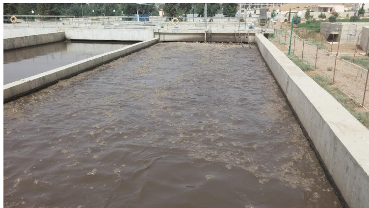
Figure II. 4 : Bassin aérobie (traitement biologique).
