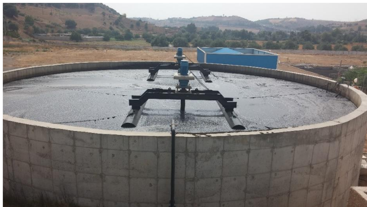
Figure II. 6 : Stabilisation aérobie des boues.
