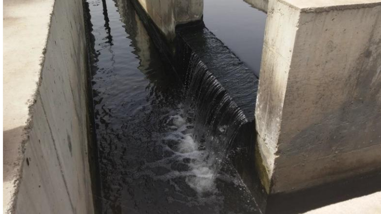
Figure II. 5 : Les chicanes de désinfection (traitement tertiaire).
