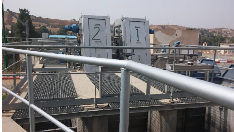
Figure II. 3 : La zone de prétraitement.
