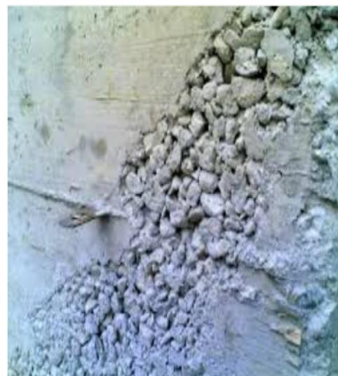
**Figure II.1.** Ségrégation externe du béton
