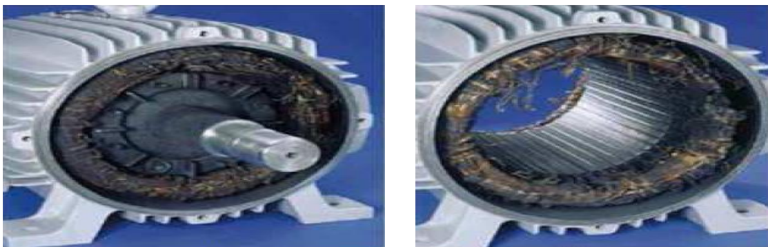
(a) Court-circuit due à un rotor bloqué
