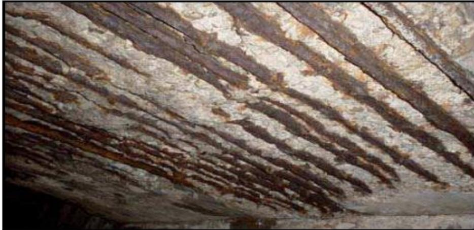
**Figure 2.2.** Les attaques des sulfates sur les armatures et le béton.
