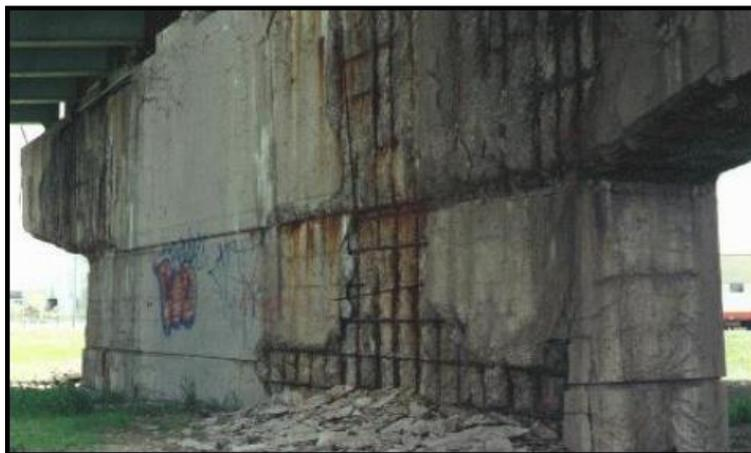
**Figure 2.4.** Agression du béton par activité des chlorures.
