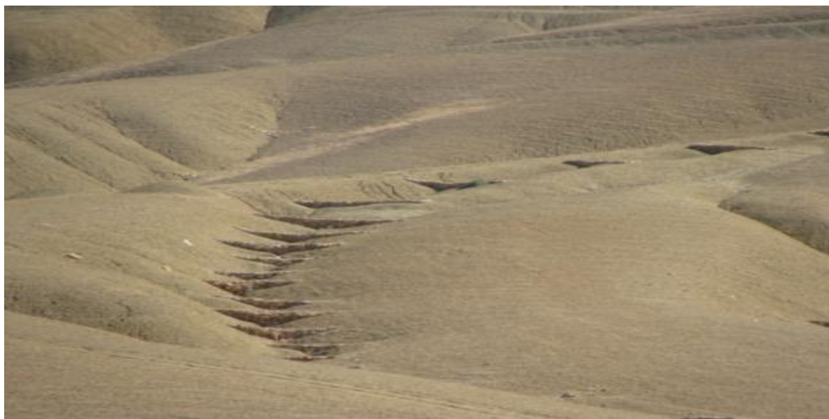
Figure III.4: Une série de seuils réalisée sur une ravine dans un bassin versant, (Remini 2014).
