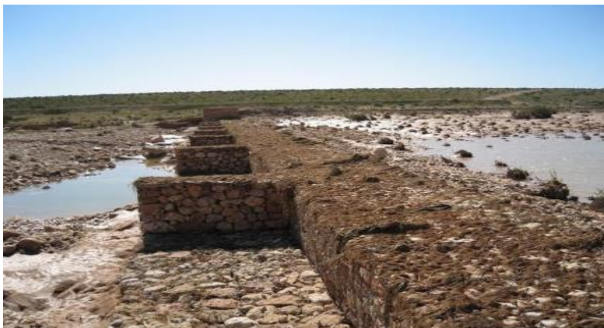
Figure III.2 : Gabionnage contre l'érosions.
