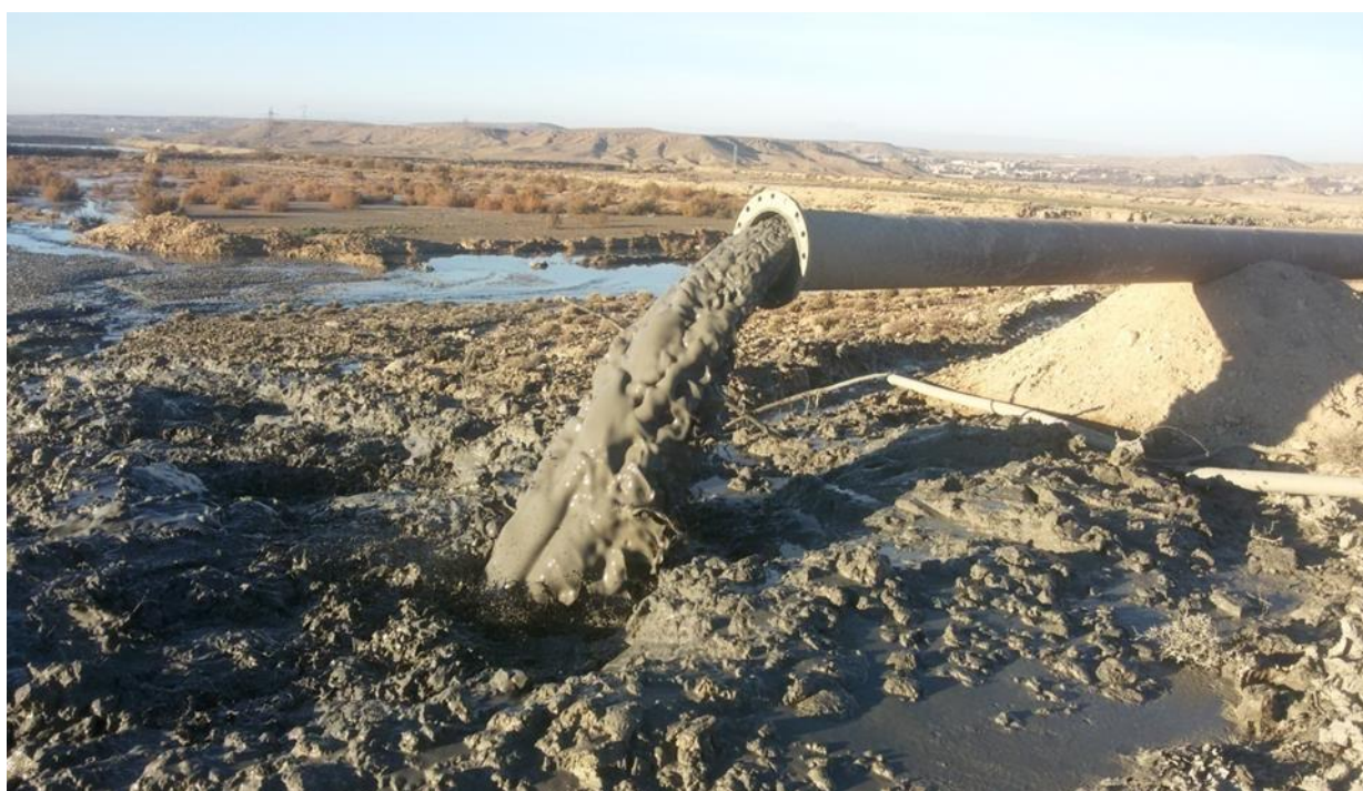
Figure III.11 : Refoulement de la vase du barrage K'sob (ANBT, 2016)
