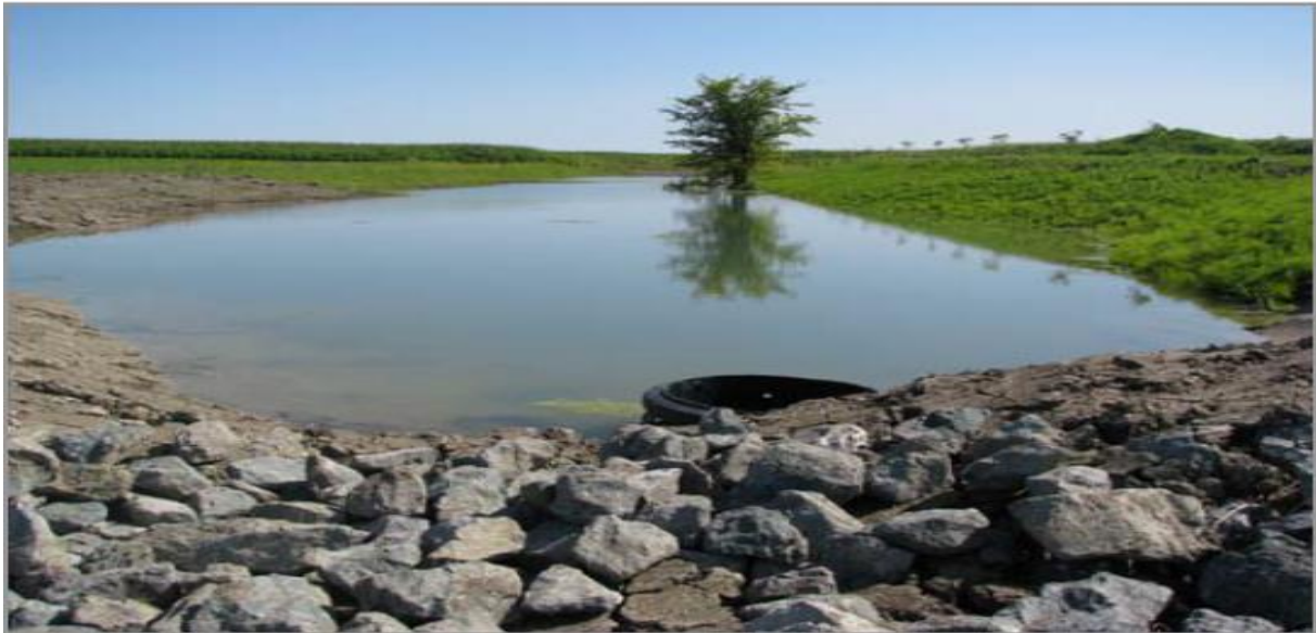
Figure V.1 : Image d'un bassin de décantation.
