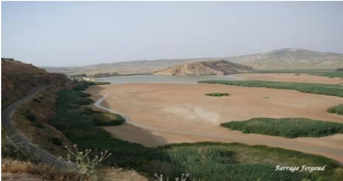
Figure I.5 : Barrage de Fergoug envasé à plus de 90 % de sa capacité en 2008.
