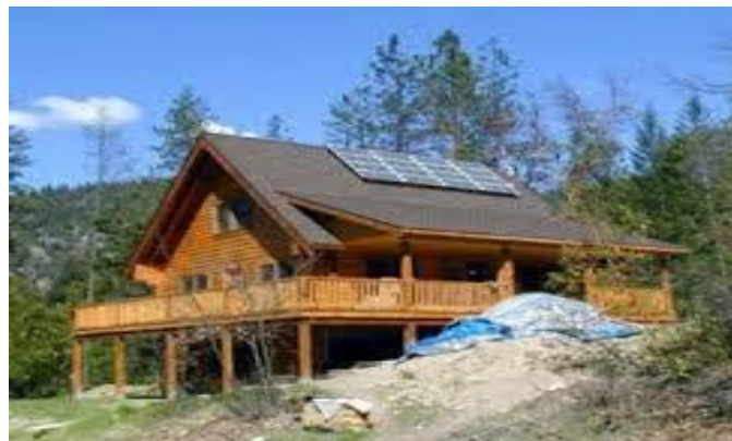
Figure I. 13 : Systèmes photovoltaïques pour le chalet
