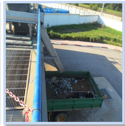
Figure 13 : Grille automatique Figure 14: Grille manuelle. Figure 15 : Benne
