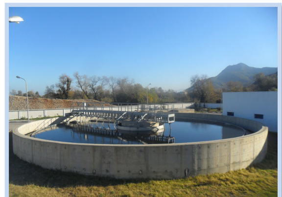
Figure 19: Décanteur secondaire.
