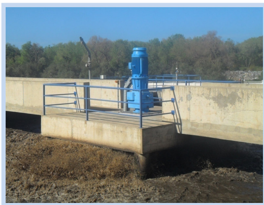
Figure 18 : Bassin d'aération.
