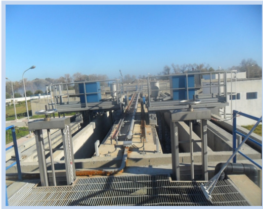
Figure N° 16: Pont déshuilage-dessablage.
