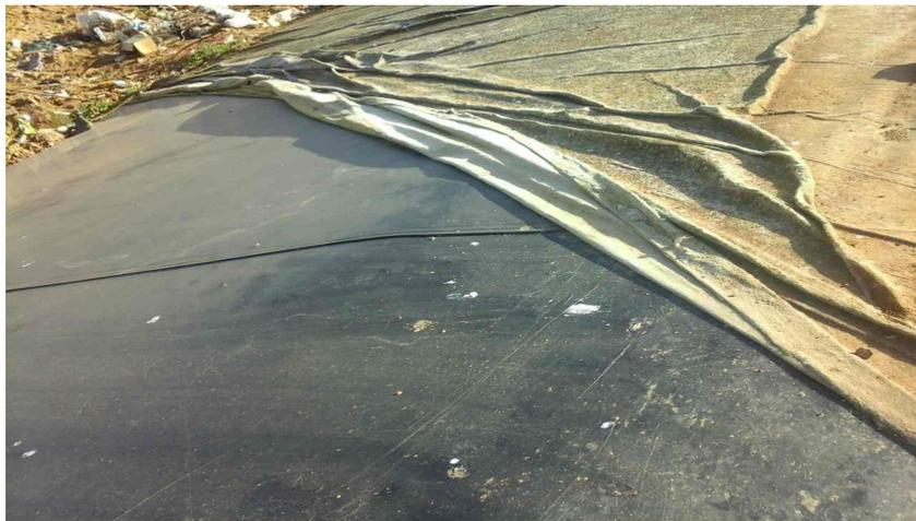
**Figure 2: Géo membrane et géotextile (Originale, 2017)**
