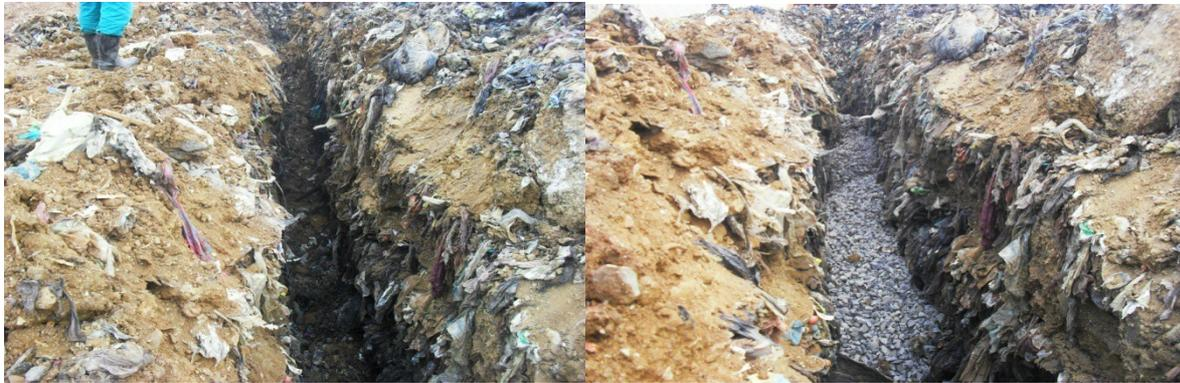
**Figure 4: Réseau de drainage des lixiviats (Originale, 2017)**
