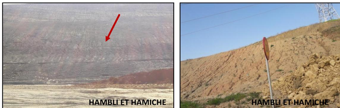
**Photo N°04 :** Erosion au niveau de la section trois.
