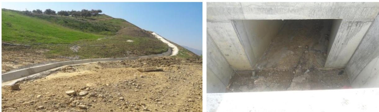
**Photo N°25 :** Système de drainage des eaux de ruissellement (caniveaux et dalots)
