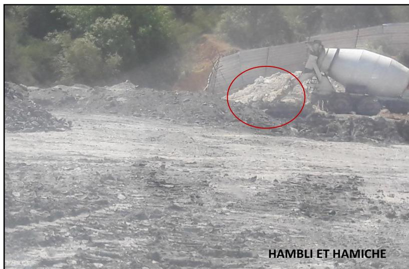
**Photo N°10** : Lavage d'une bétonnière au niveau de la section 2
