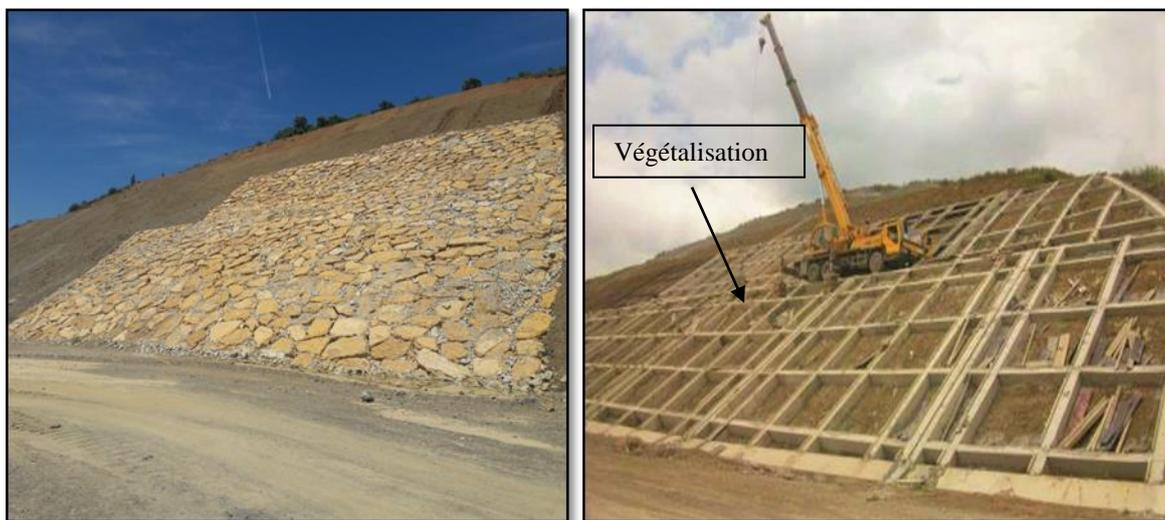
**Photo N°24:** Fixation du talus par enrochement et végétation.
