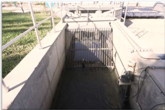
Figure 9 : Dégrilleur grossier (16/04/2017)
