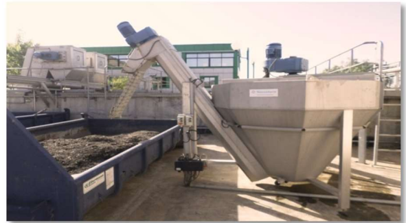
Figure 13 : Laveuse de sable (16/04/2017)
