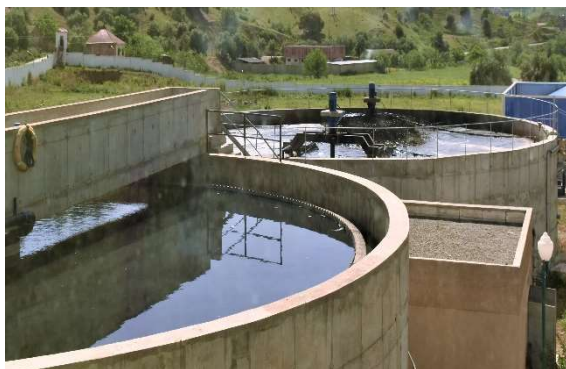
Figure 18 : Epaississeurs de boue (16/04/2017)
