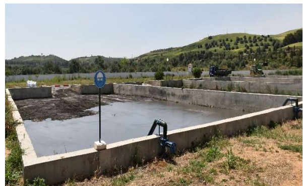
Figure 19 : Lits de séchage (16/04/2017)
