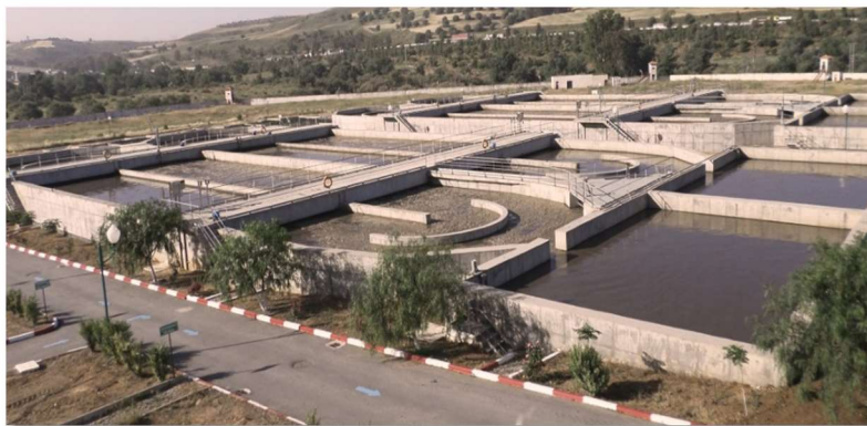
Figure 15 : Bassins d'aération (16/04/2017)
