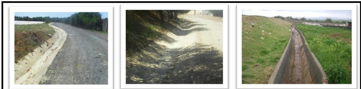
Figure n ° 10 : Curage et nettoyage des caniveaux d'eaux pluviales [18].
