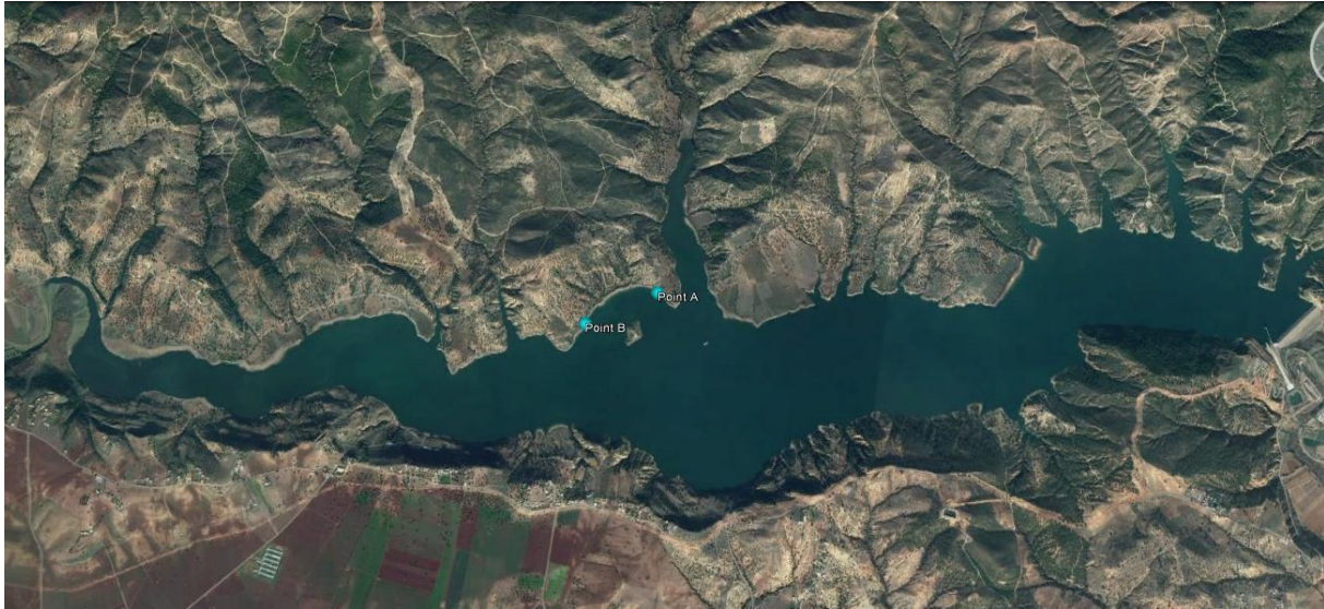
Figure 2 : Localisation géographique du barrage de Tiledit. A et B caractérisent les deux points d'échantillonnage. (Image Google earth)
