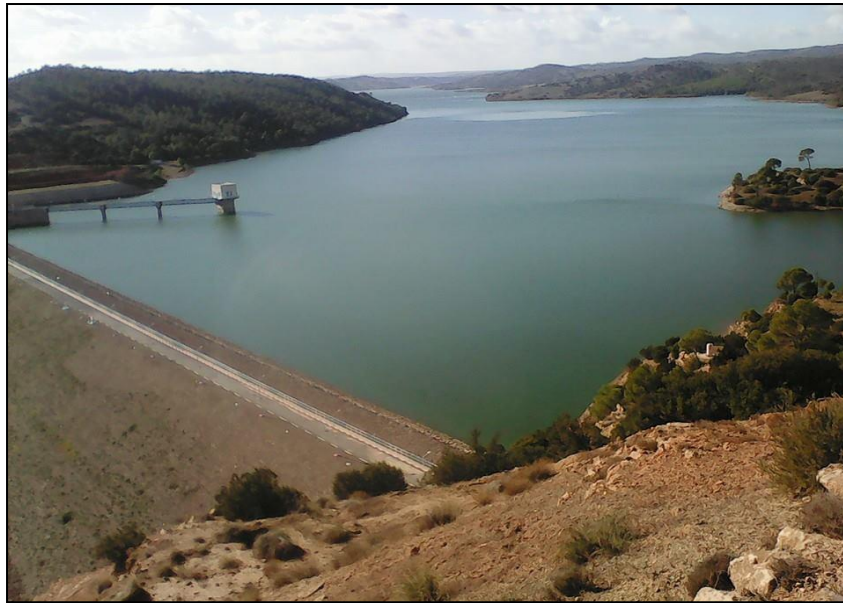
Figure n °10 : Barrage Tilesdit.
