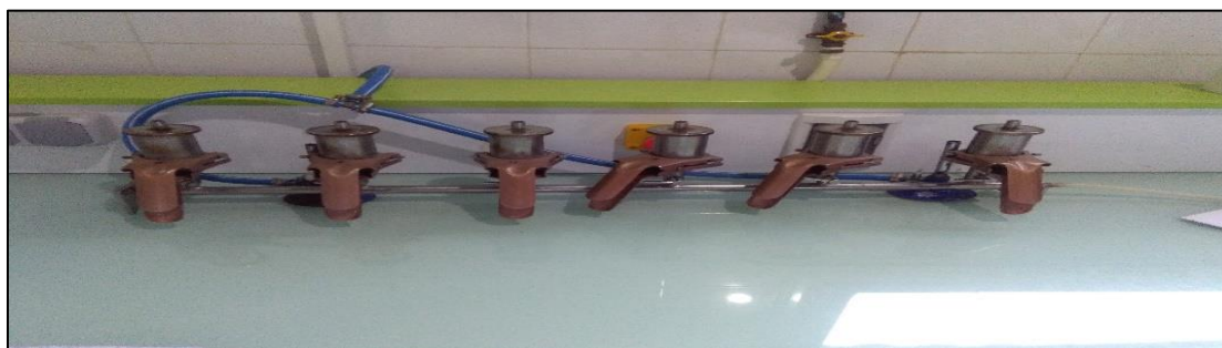
Figure n° 13 : Rampe de filtration
