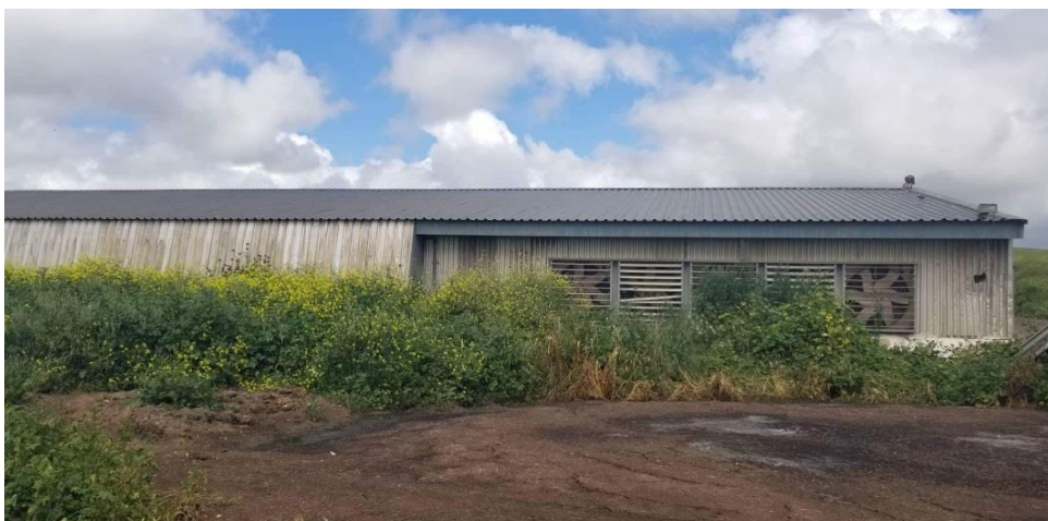
Figure 18: Disposition des extracteurs d'air dans élevage (photo personnelle).
