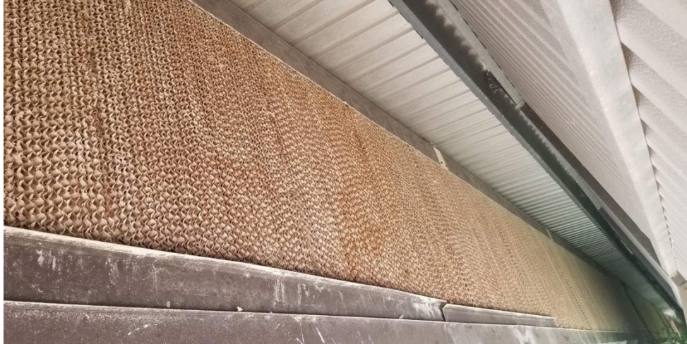
Figure 19 : Système d'humidification (photo personnelle).
