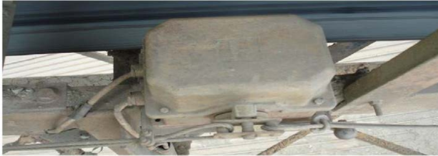
Figure II.25: illustre l'emploi d'un câble de sécurité.
