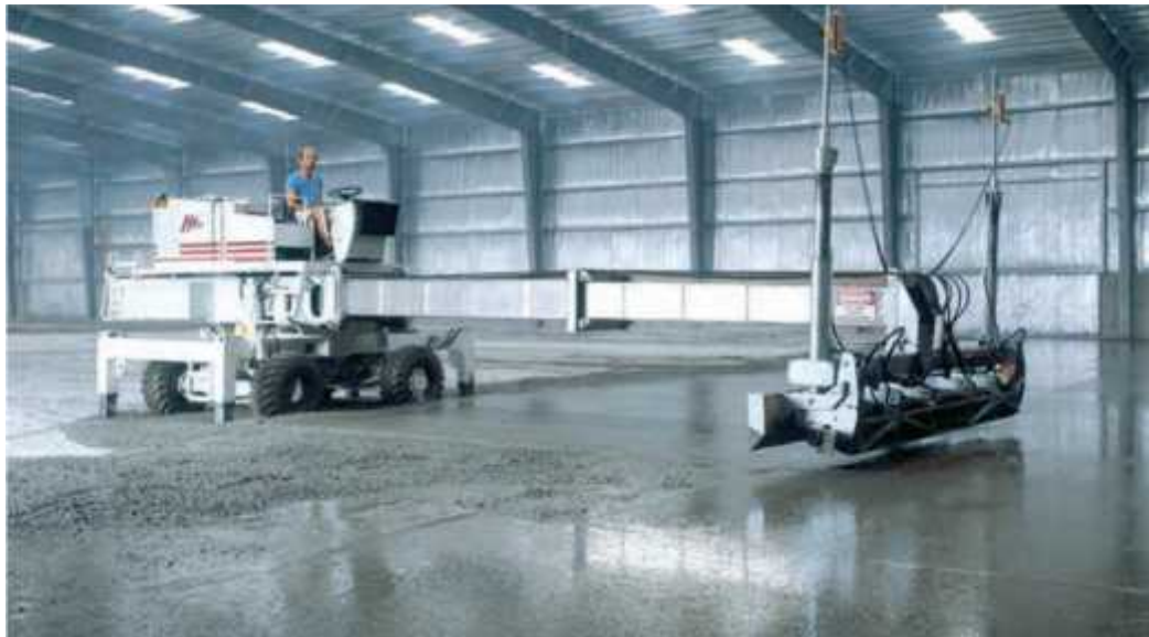
Figure I.5 – utilisation des fibres métalliques dans les dallages industriels
