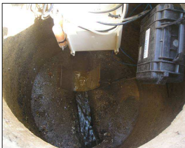
Installation du bulle à Bulle +doppler dans un regard
