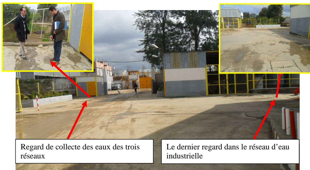
Figure 17: localisation du réseau d'évacuation des effluents industriels
