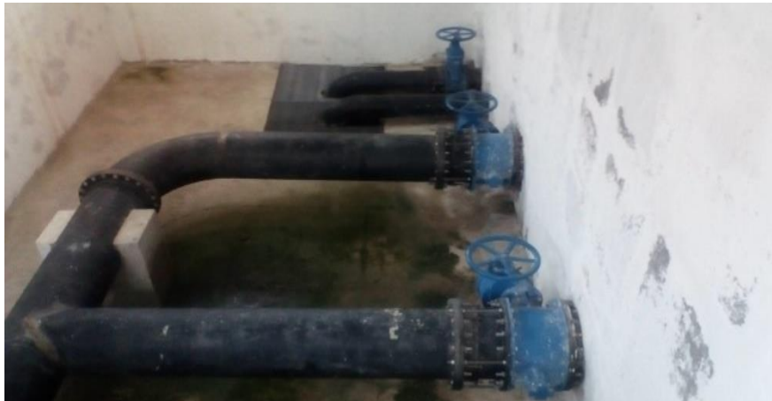
Figure II.3 : Photo de la salle de vidange [19].
