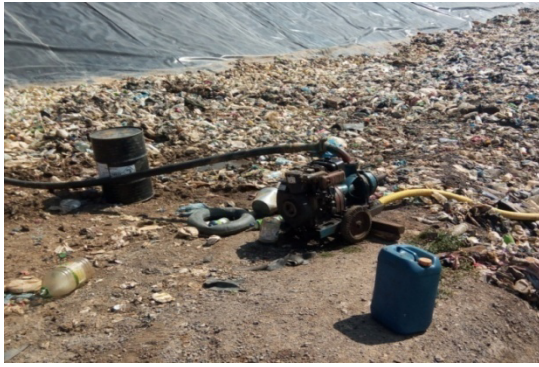
figure 55: la transmission de lixiviat par une pompe.
