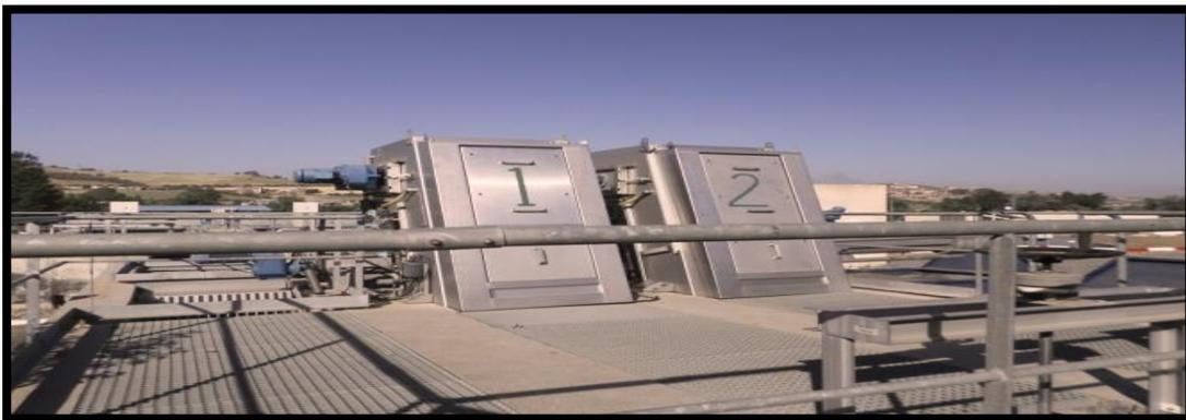
**Figure n°4 :Dégrilleurs fins**
