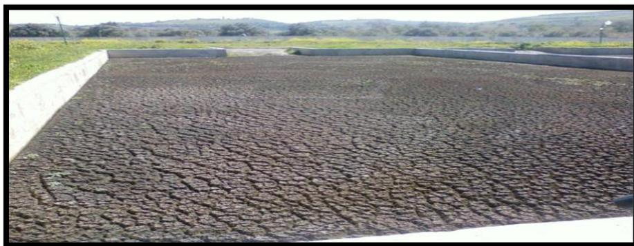
Figure n° 15: Déshydratation en lit de séchage.
